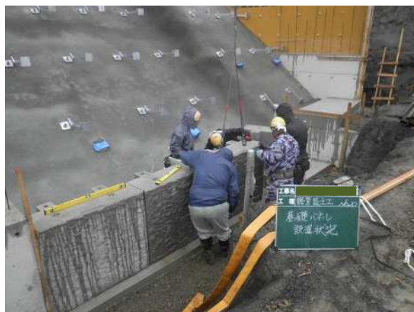
基礎パネル設置状況
