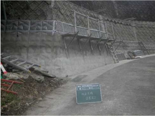
ブロック積み補強施工中
