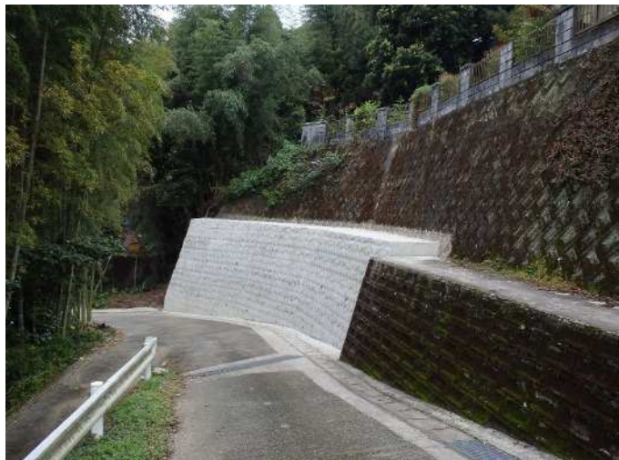
ブロック積み補強増打工事完成
