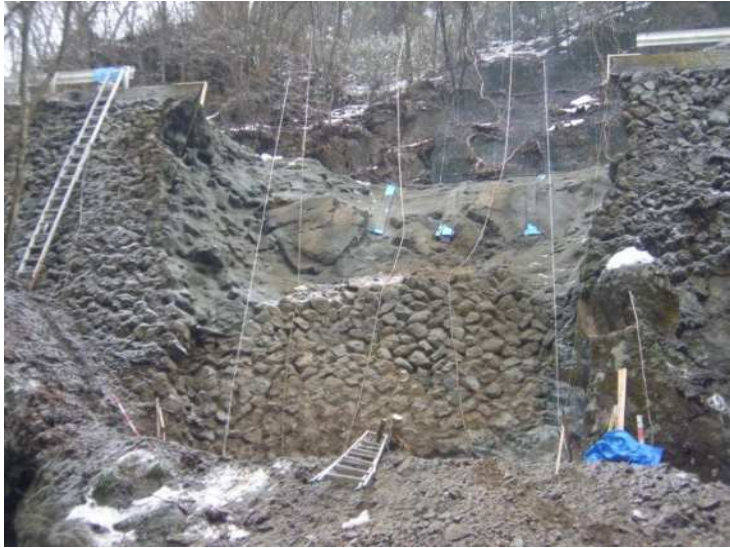
オーバーハングの土砂と浮石の除去。
