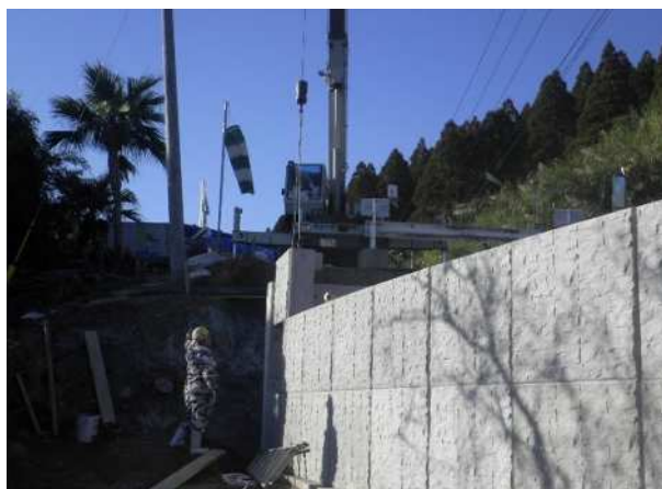
パネル設置状況
