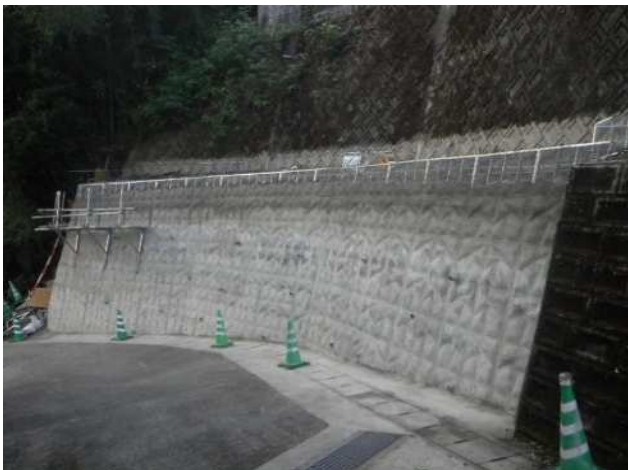
ブロック積み補強施工中
