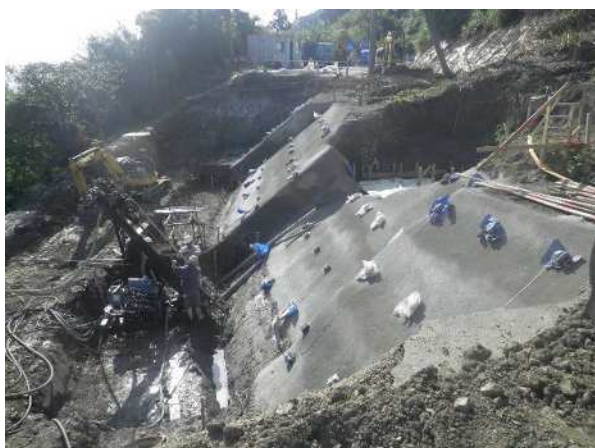
鉄筋挿入工 作業状況
