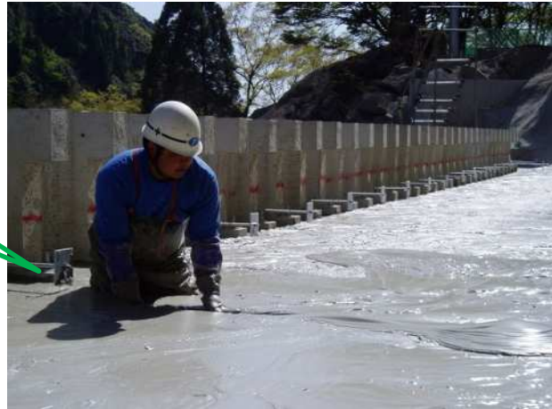
補強金網(φ3.2・100×100)打設
