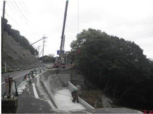
防水シート(t=1mm)敷設
