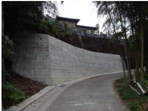
ブロック積み補強増打工事完成
