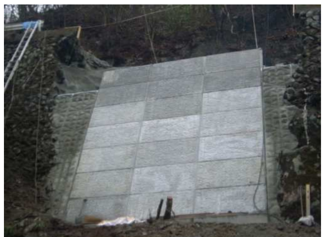
外部足場なしで、壁面を構築して、軽量盛土を打設する。
