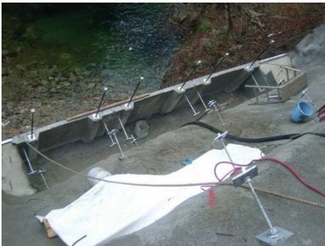
モルタル吹付と鉄筋挿入工で地山を補強の後、基礎と壁面パネルの構築。
