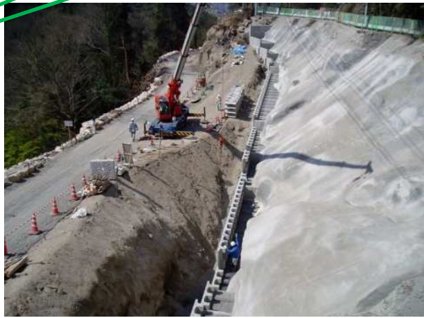
PCWパネル設置 (25tクレーン使用)
