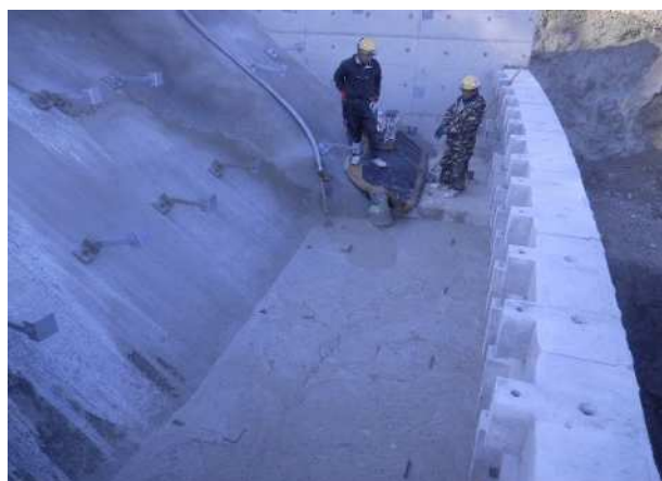
気泡混合軽量土打設状況
