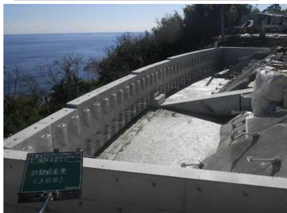
外部足場なしでの壁面および 気泡混合軽量盛土を施工
