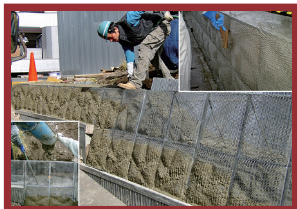
コンクリートの打設
