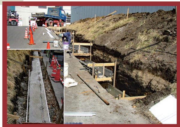
基礎コンクリートの施工
