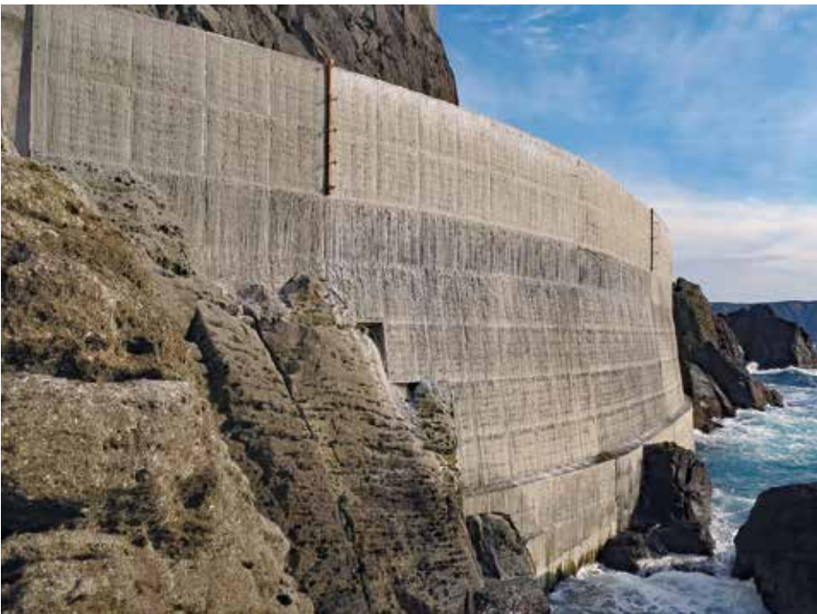
施工完了状況
