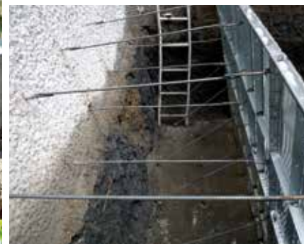
<上>組立前状況 <下>組立状況
