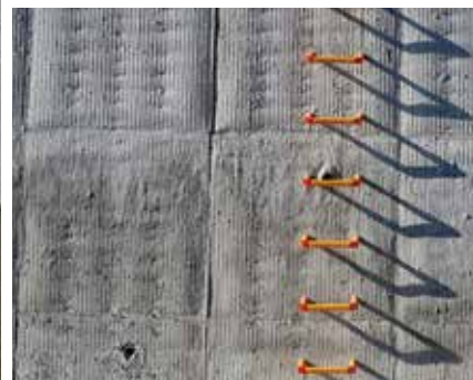
<上>普通型枠との組合せ施工前状況 <下>昇降階段設置状況
