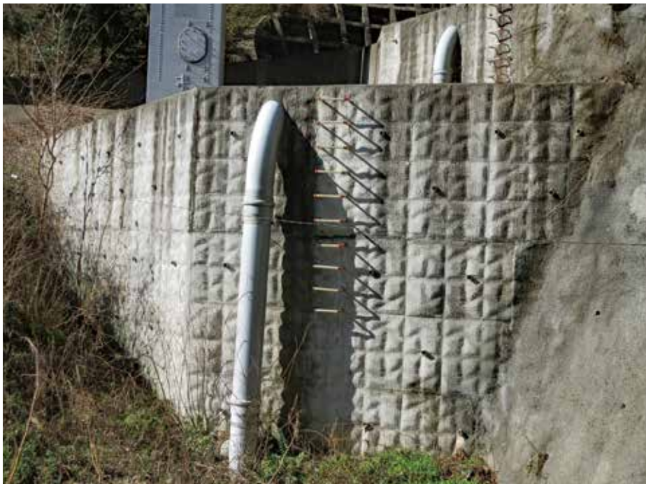
施工後9年状況
