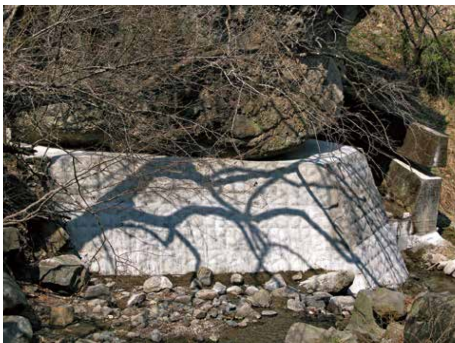
施工完了状況
