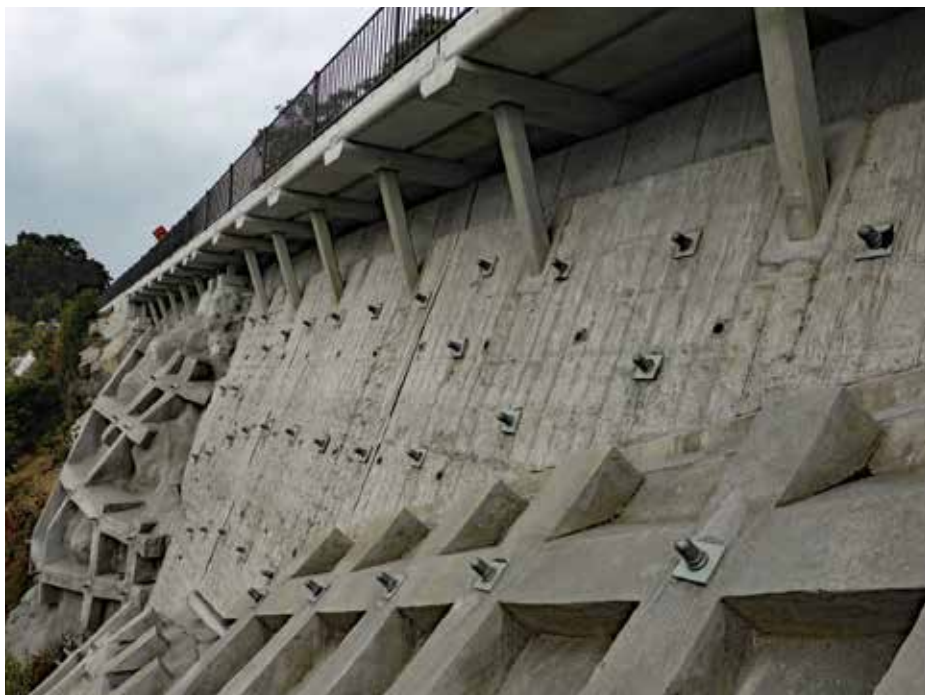
施工完了状況
