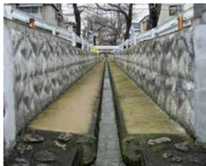
<上>施工前状況 <下>施工完了状況
