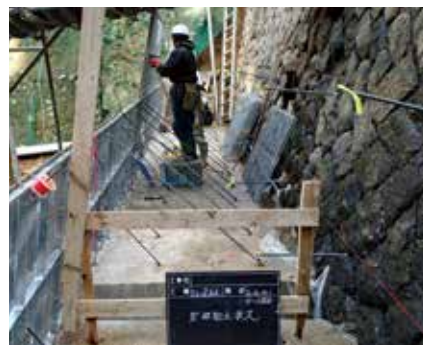
<上>施工前状況 <下>組立状況
