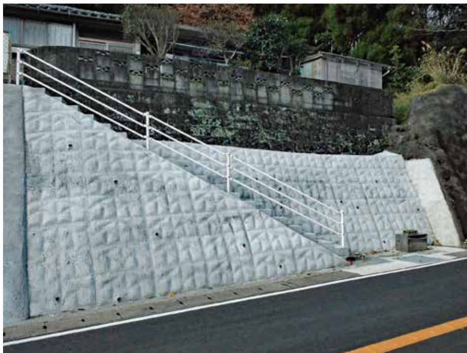
施工完了状況
