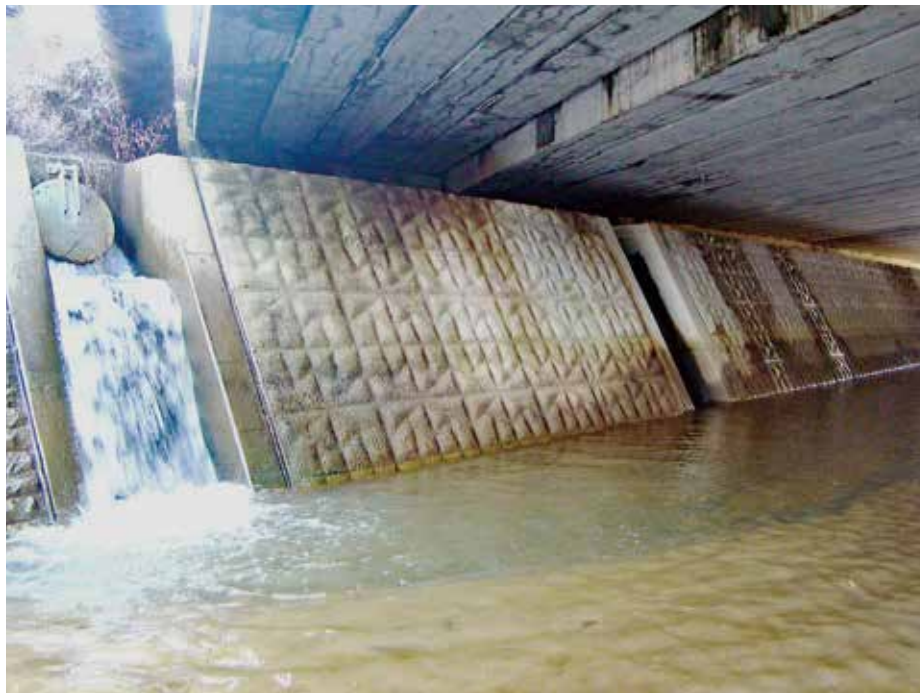
施工後3年状況
