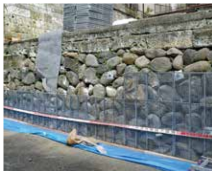
<上>施工前状況 <下>組立状況
