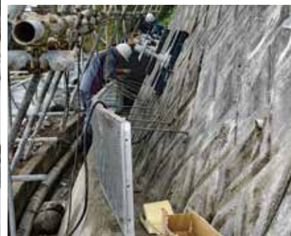
<上>施工前状況 (切土補強土工完了状況) <下>組立状況
