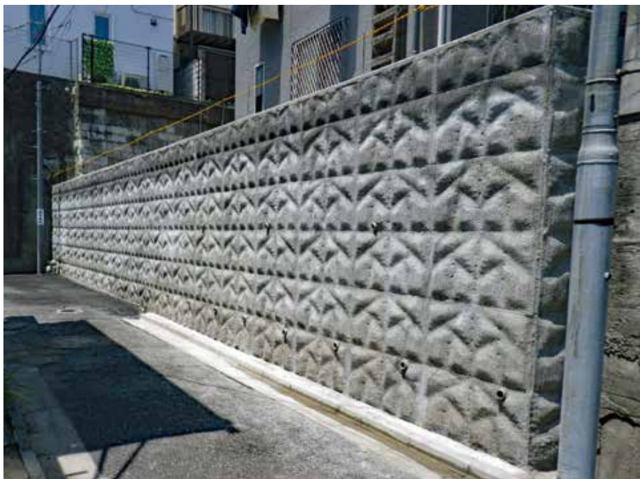
施工完了状況
