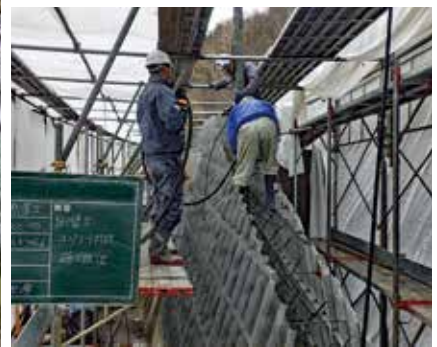
<上>施工当初状況 <下>寒中コンクリート打設状況
