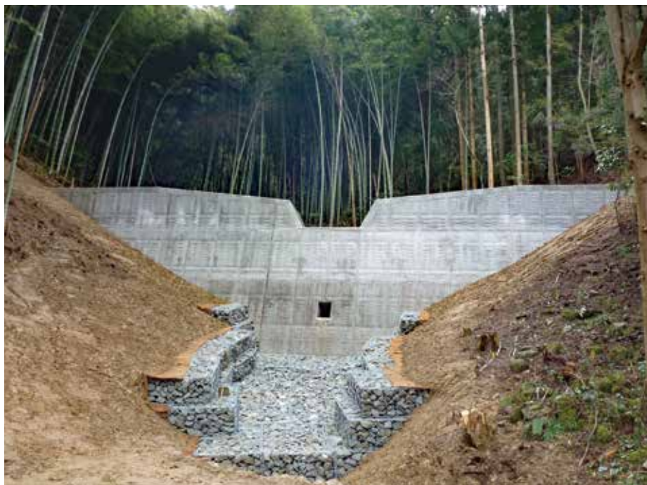
施工完了状況
