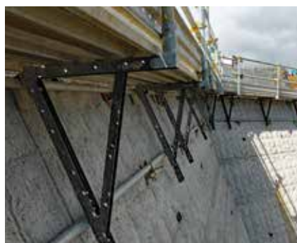
<上>施工前状況 <下>簡易足場設置状況
