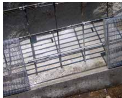
<上>組立状況 <下>配筋状況
