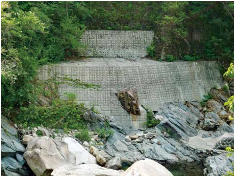
施工後3年状況
