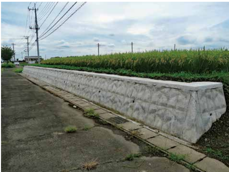
施工完了状況
