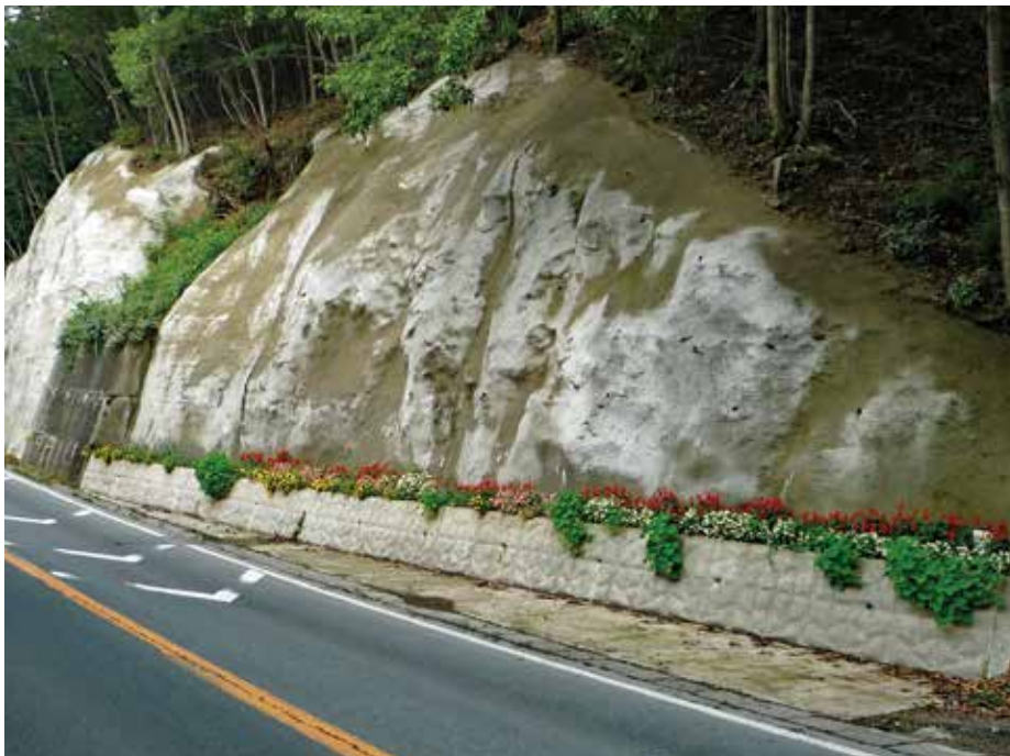
施工完了状況
