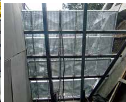
<上>コンクリート打設状況 <下>組立状況(背面)
