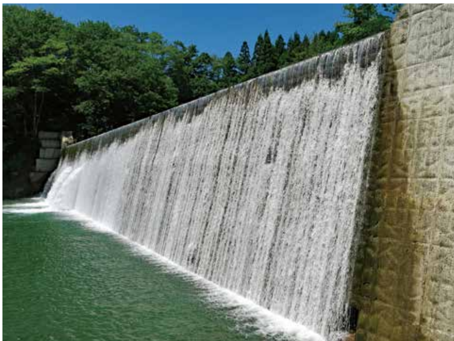
施工後3年状況
