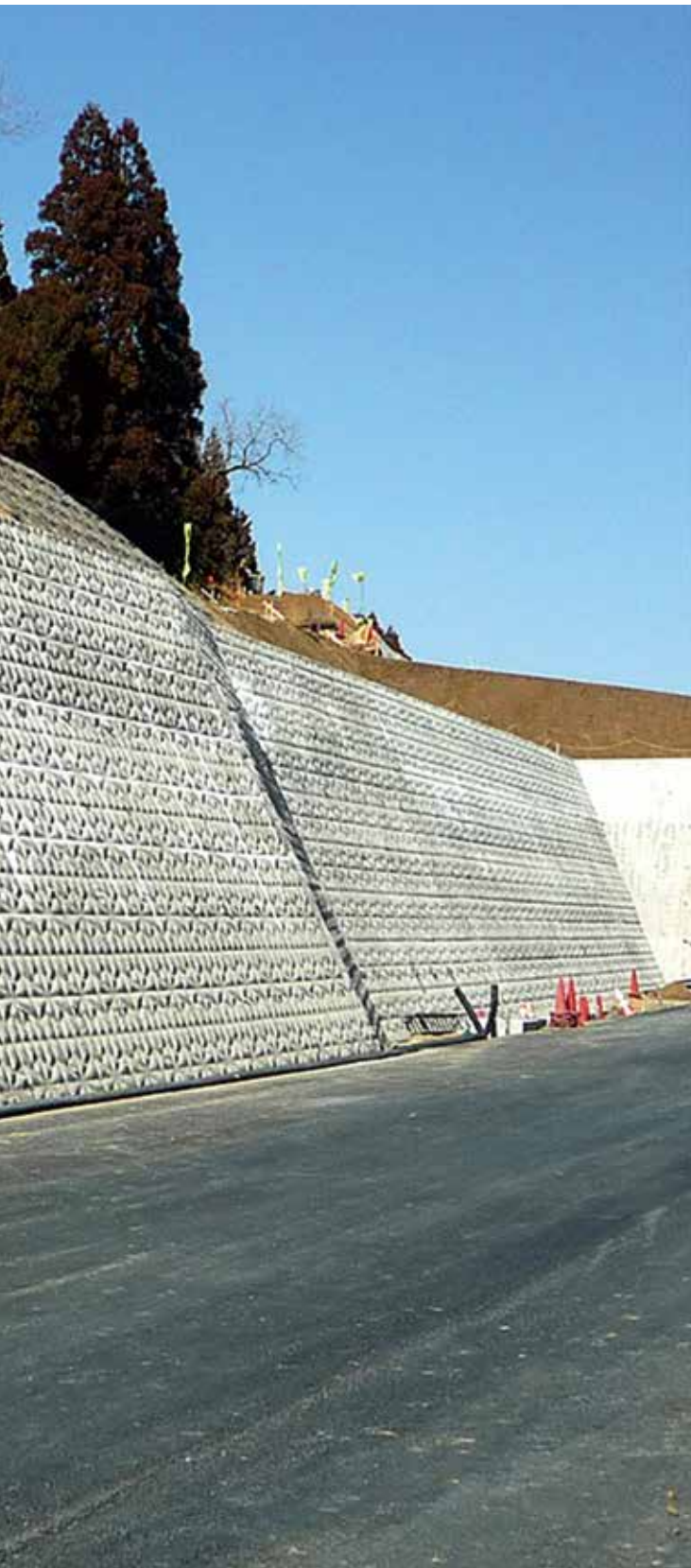
切土補強土工完了状況
