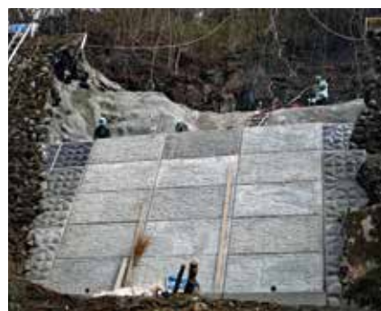
<上>組立状況(背面) <下>施工状況
