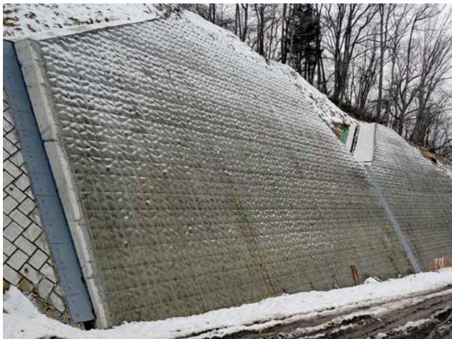
施工完了状況
