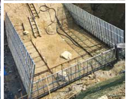
<上>丘組状況 <下>丘組材現場設置状況
