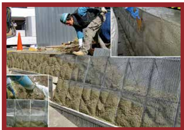
コンクリートの打設
