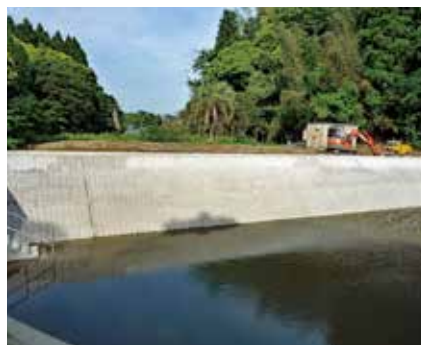
<上>組立状況 <下>施工完了状況(満水時)
