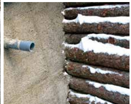
<上>組立状況 <下>端部処理状況
