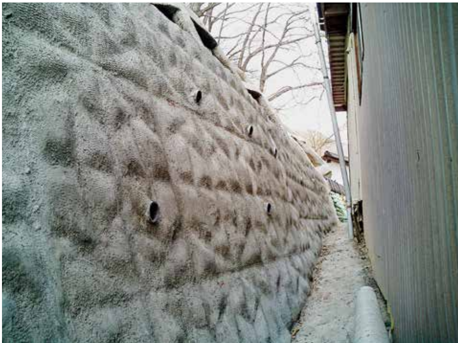
施工完了状況
