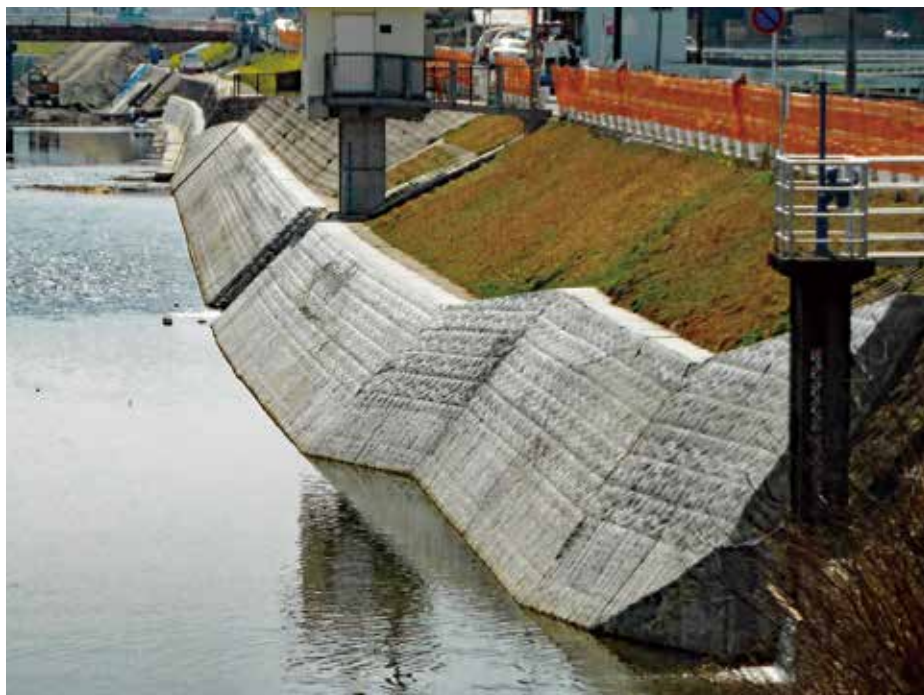
施工完了状況
