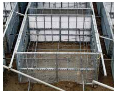
<上>組立完了状況(遠景) <下>組立完了状況(近景)
