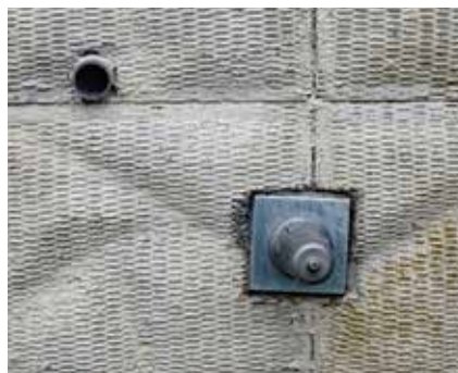
<上>施工前状況 <下>切土補強土工、水抜きパイプ設置状況
