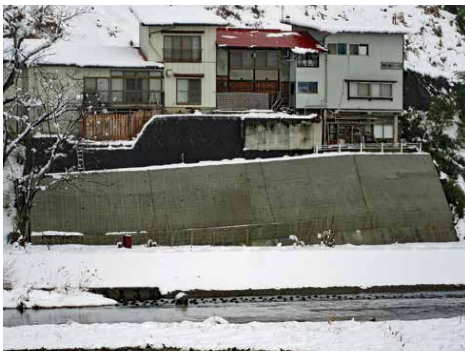
施工完了状況
