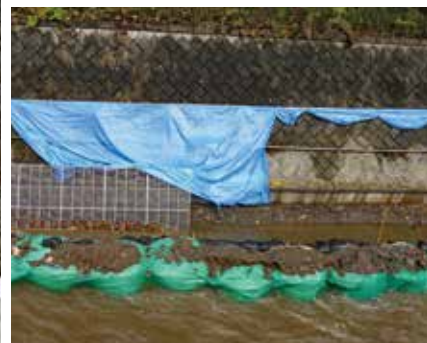
<上>施工当初状況 <下>組立状況
