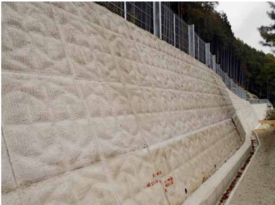
施工完了状況
