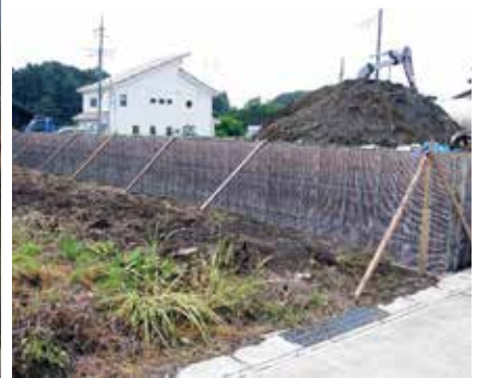
<上>配筋状況 <下>組立完了状況
