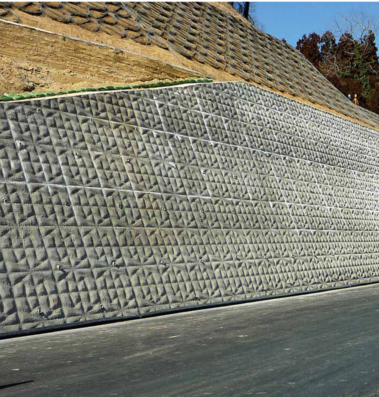
施工完了状況
