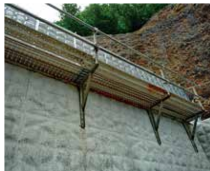
<上>施工状況 <下>簡易足場設置状況
