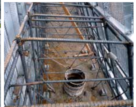
<上>組立状況(遠景) <下>組立状況(近景)
