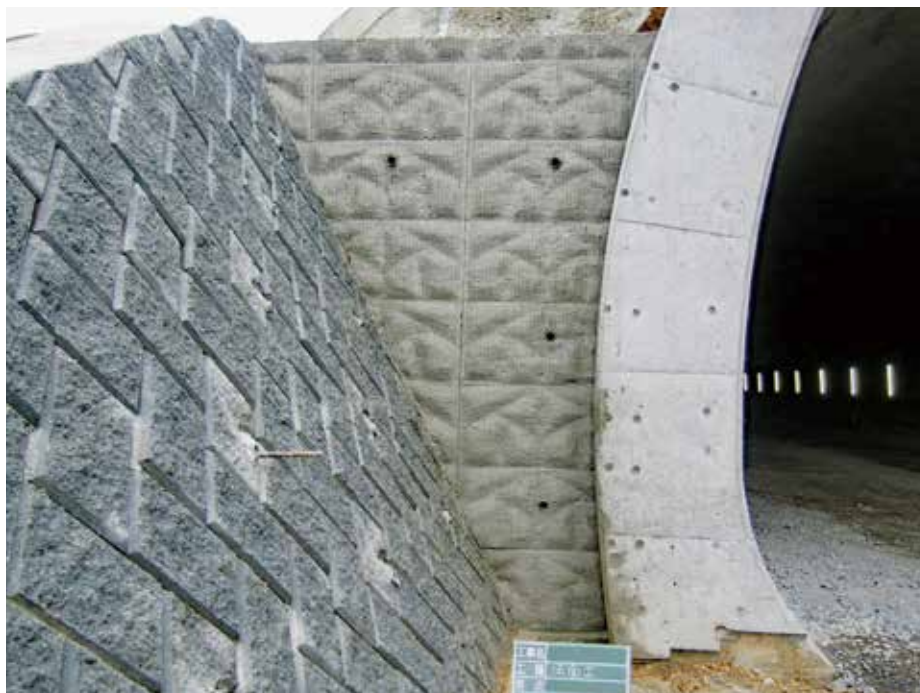
施工完了状況
