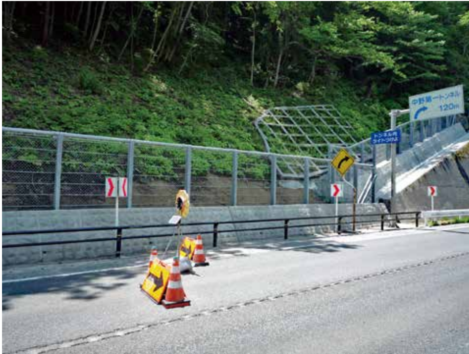
施工完了状況
