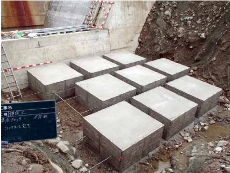
施工完了状況
