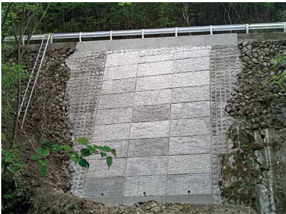
施工完了状況
