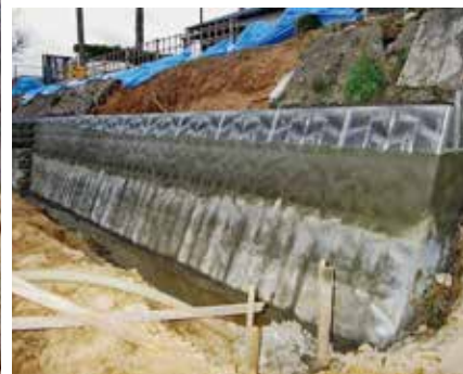
<上>デコメッシュ置くだけタイプ <下>施工状況
