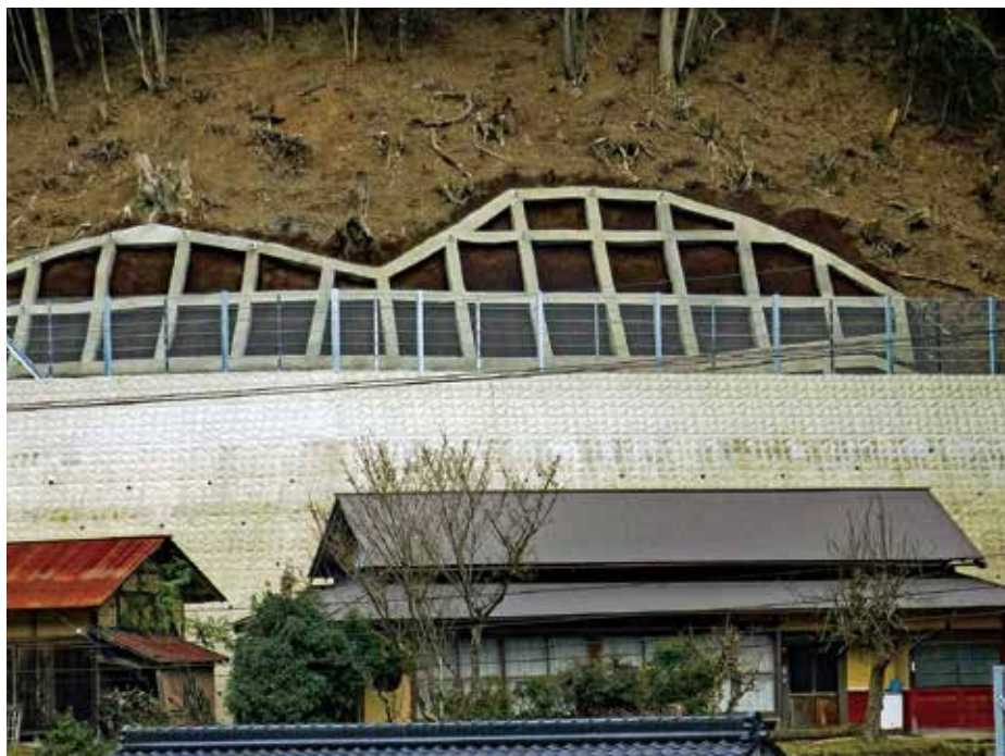
施工完了状況
