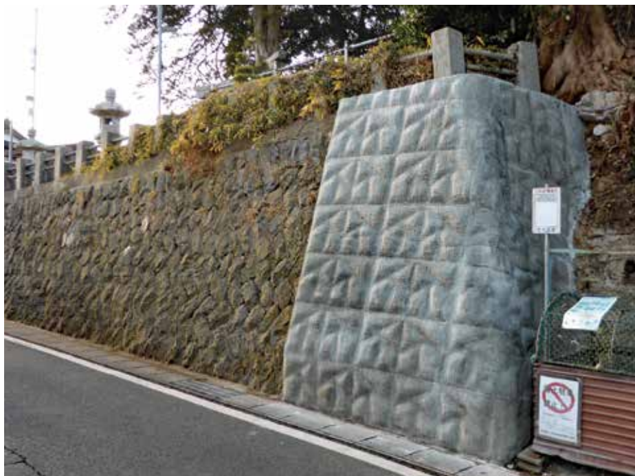
施工完了状況
