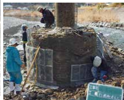
<上>施工前状況 <下>組立状況
