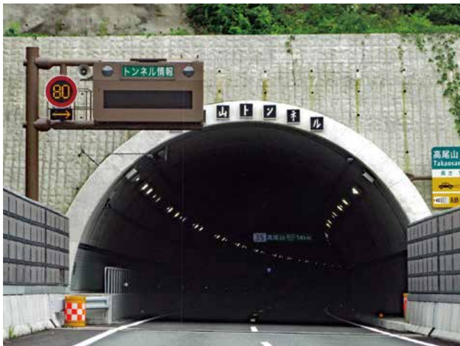
施工完了状況
