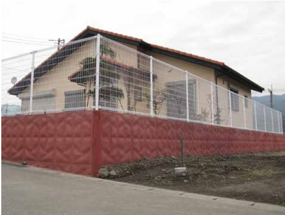
施工完了状況
