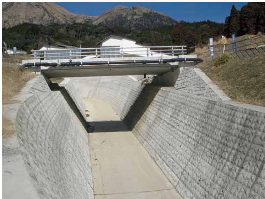
施工完了状況
