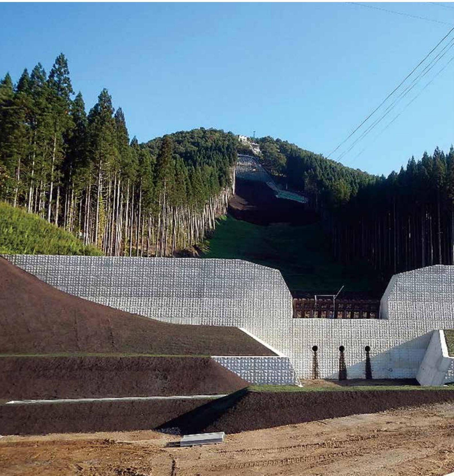
施工完了状況
