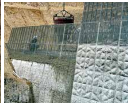
<上>鉛直打継組立状況 <下>コンクリート打設状況
