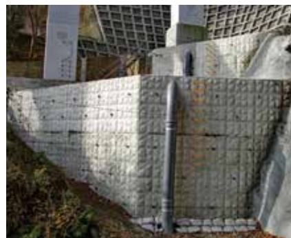
<上>背面埋設型枠支保工状況 <下>施工完了状況
