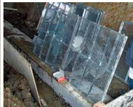
<上>施工後1年状況 <下>組立状況
