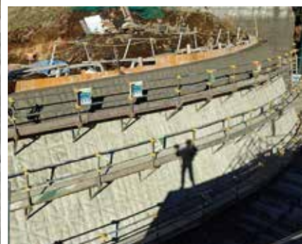
<上>組立完了状況 <下>コンクリート打設完了状況
