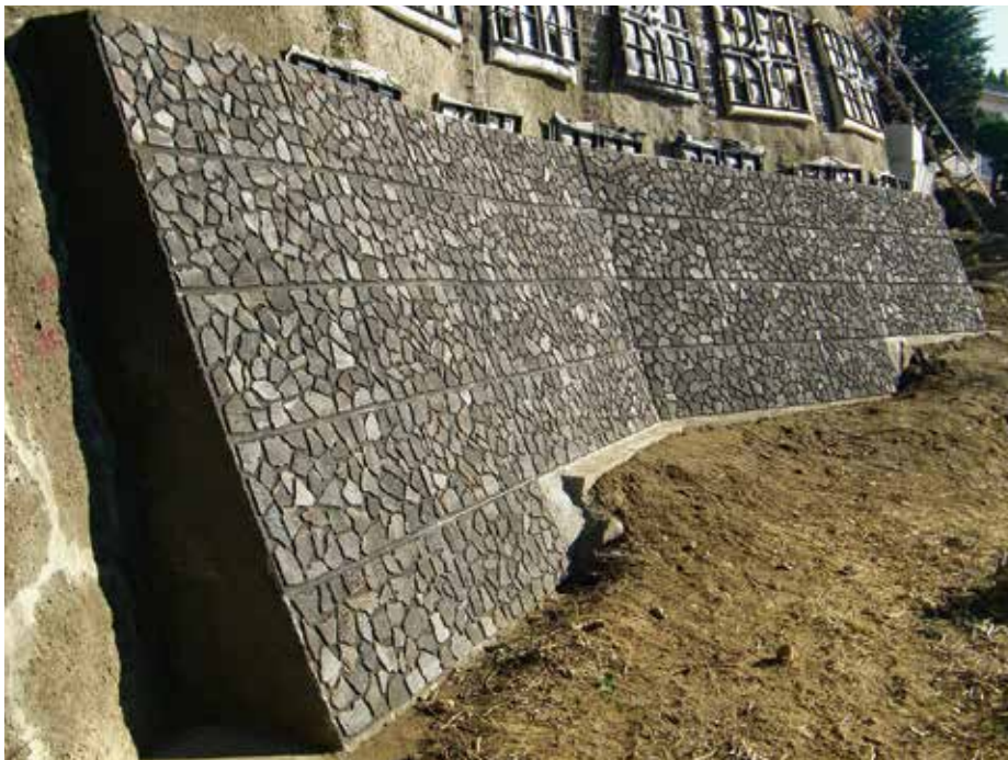
施工完了状況
