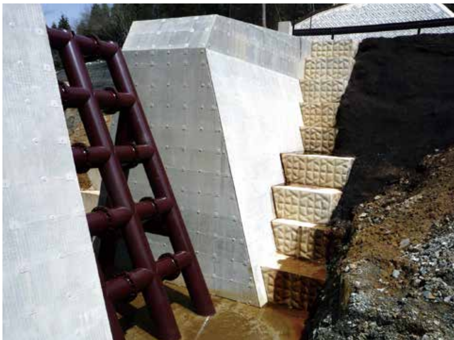
施工完了状況
