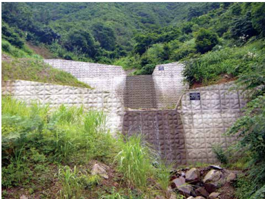
施工完了状況
