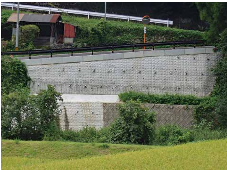
施工完了状況
