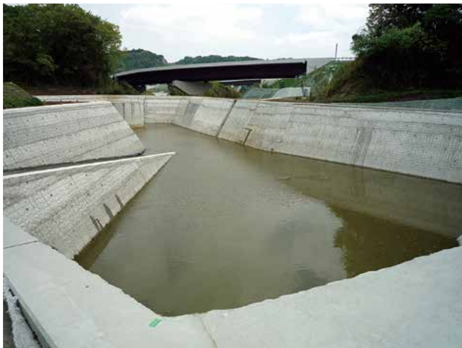
施工完了状況
