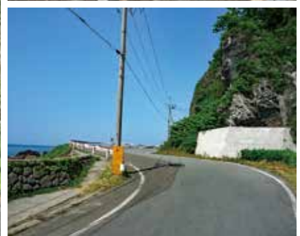
<上>折れ点の加工状況 <下>施工完了状況
