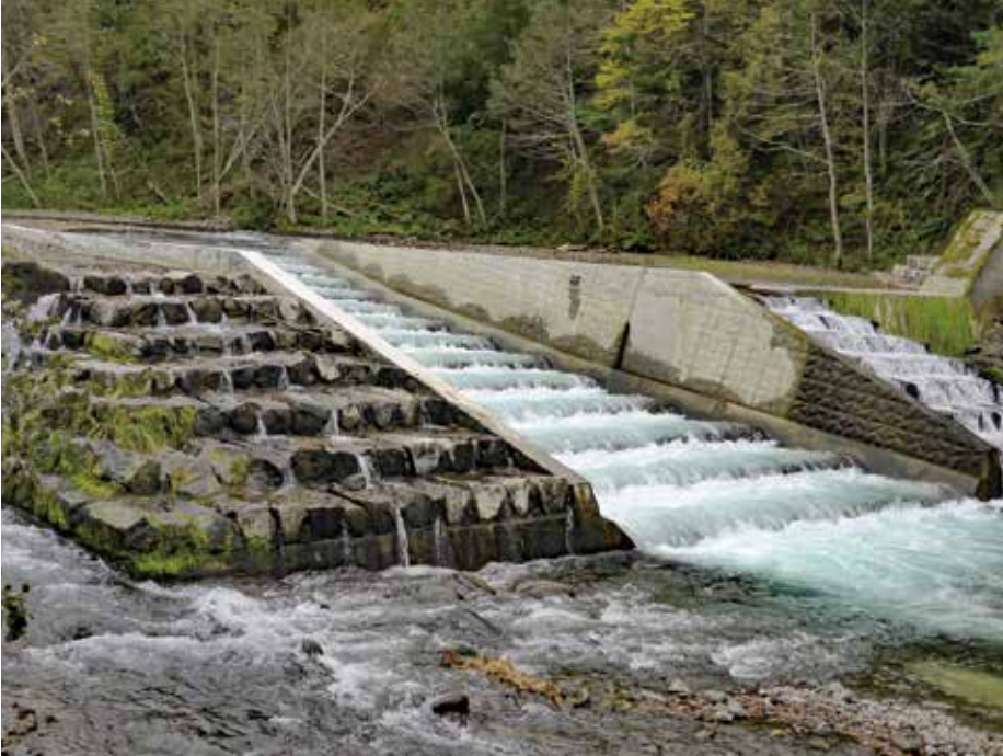
施工完了状況
