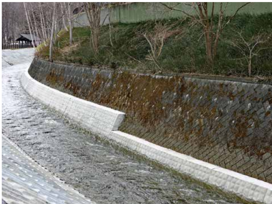
施工完了状況
