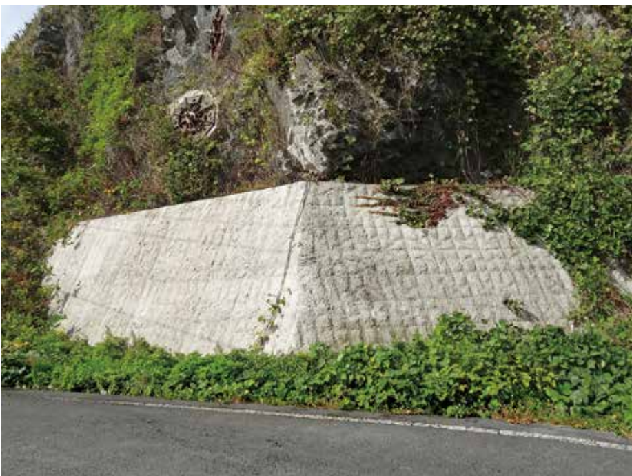
施工後5年状況
