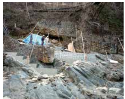
<上>組立状況 (近景) <下>組立状況 (遠景)
