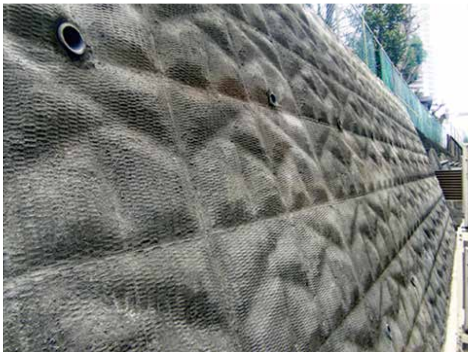
施工完了状況
