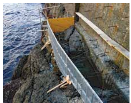
<上>施工前状況 <下>施工状況
