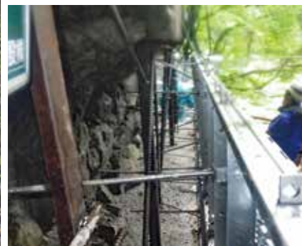
<上>組立状況(遠景) <下>組立状況(近景)
