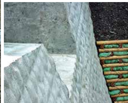
<上>施工前状況 <下>天端仕上げ状況
