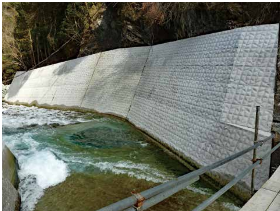
施工完了状況
