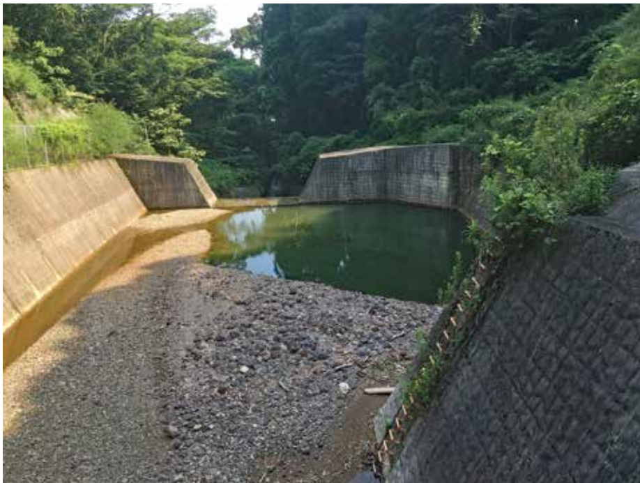
施工後7年状況
