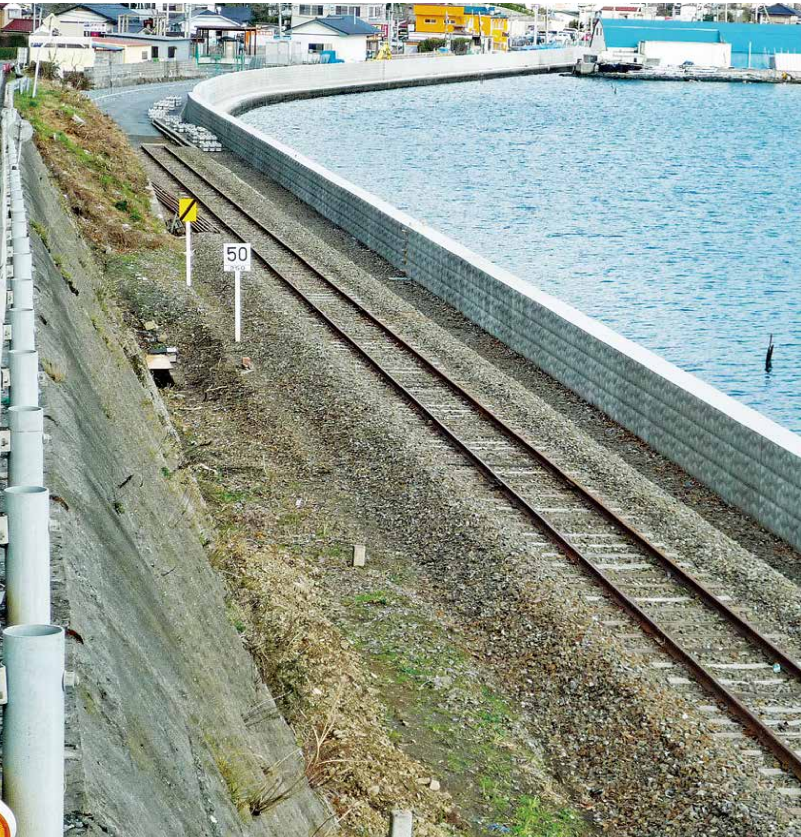
施工完了状況
