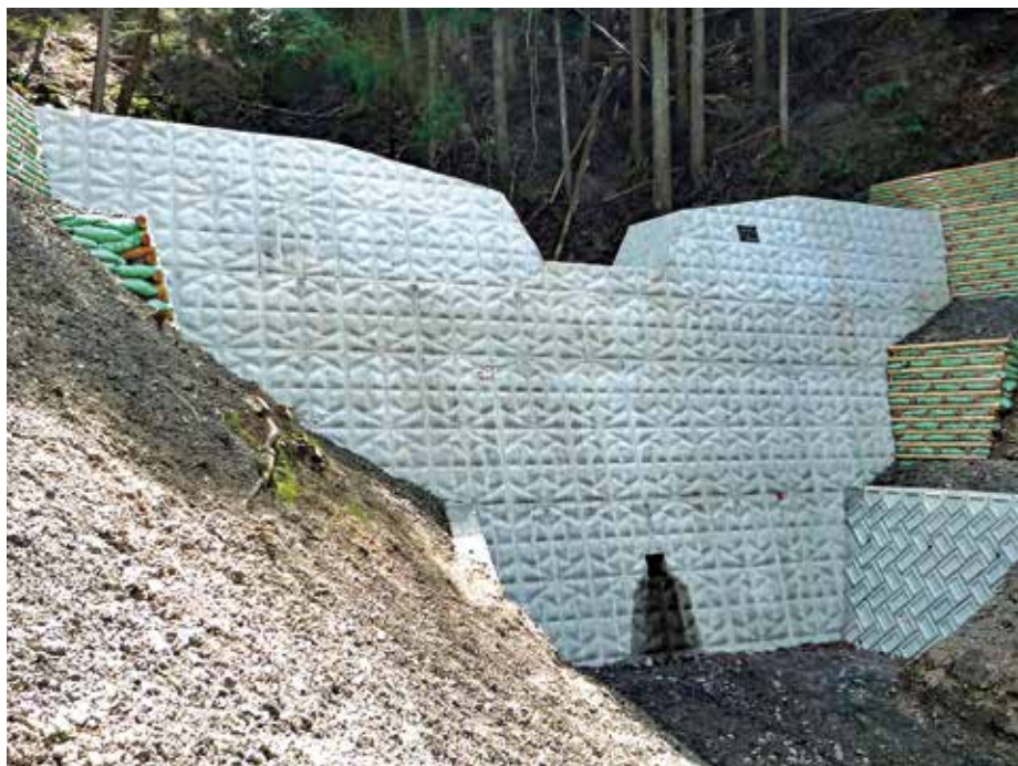
施工完了状況
