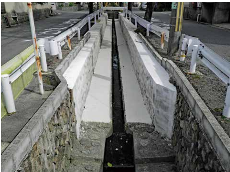
施工完了状況
