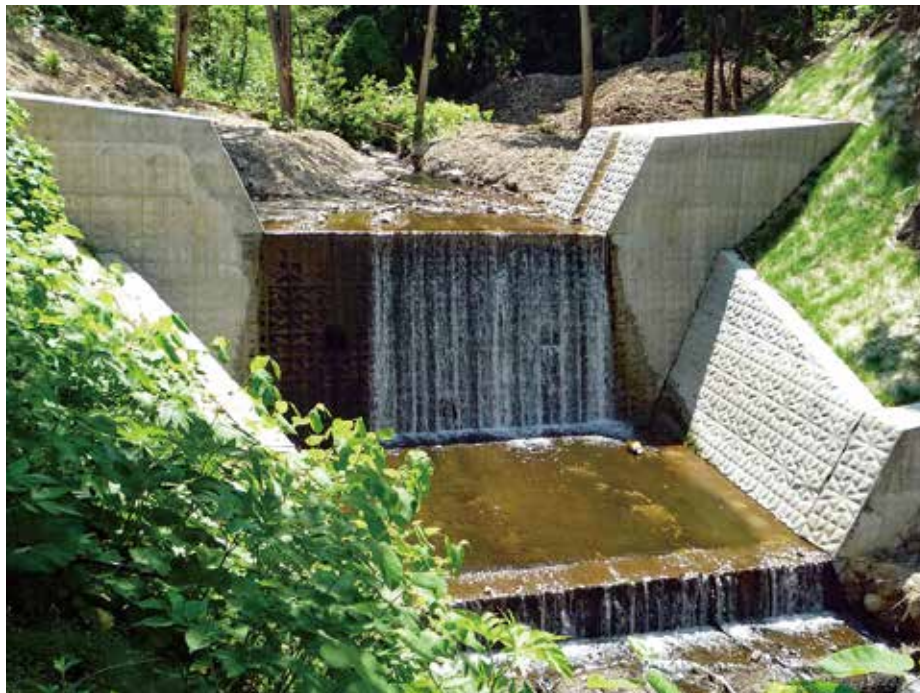
施工後2年状況
