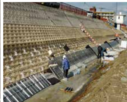
<上>施工前状況 <下>組立状況
