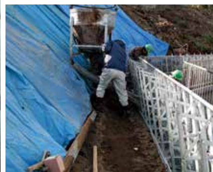
<上>デコメッシュ置くだけタイプ設置状況 <下>コンクリート打設状況
