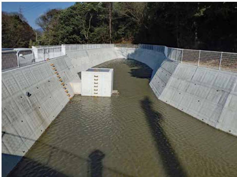
施工完了状況
