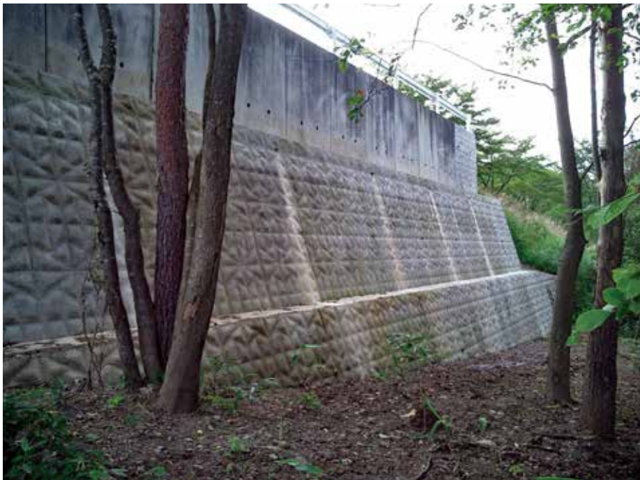
施工完了状況
