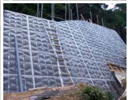
<上>コンクリート打設状況 <下>組立完了状況
