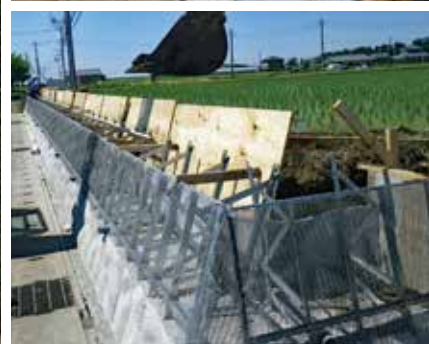
<上>デコメッシュ置くだけタイプ設置状況 <下>施工状況
