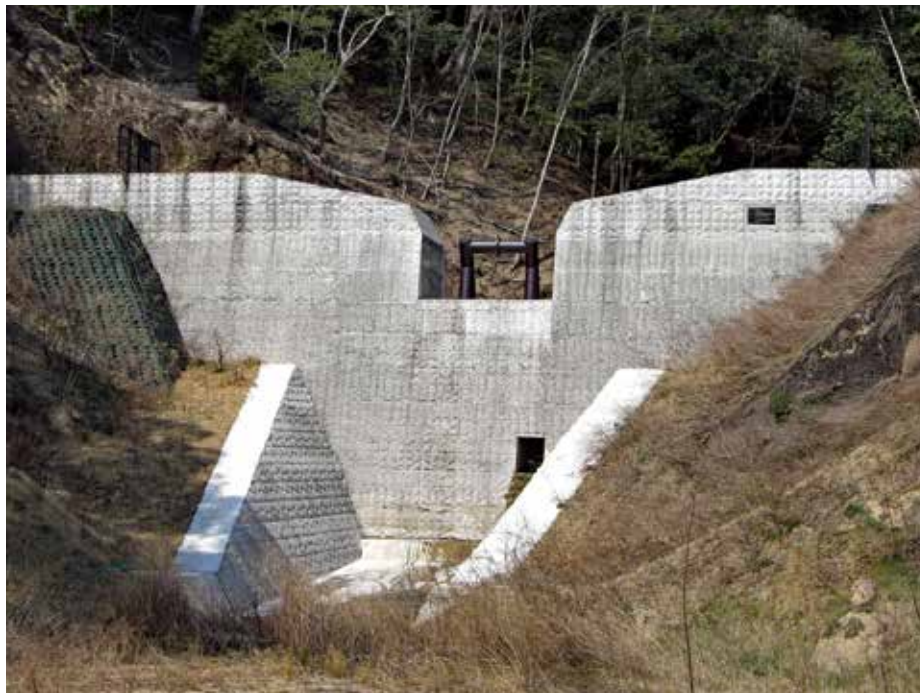
施工完了状況
