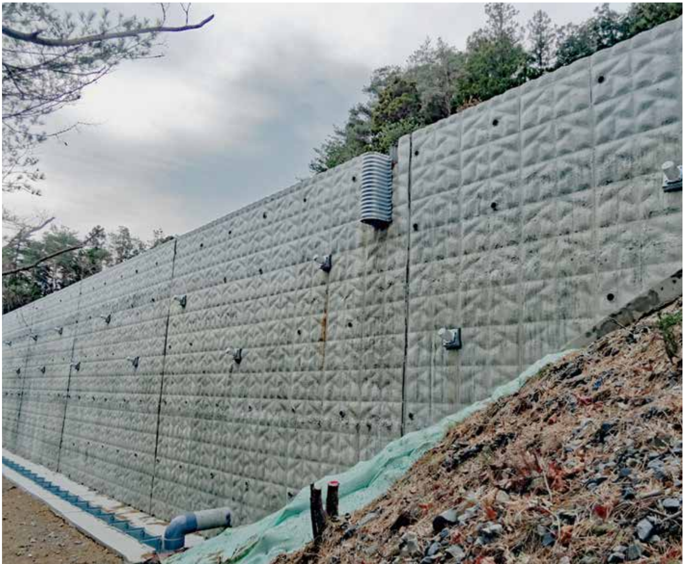
施工完了状況
