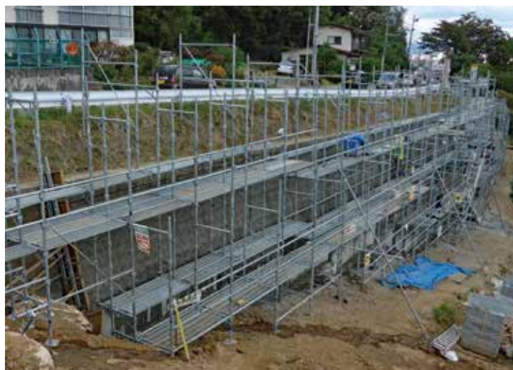
足場設置状況
