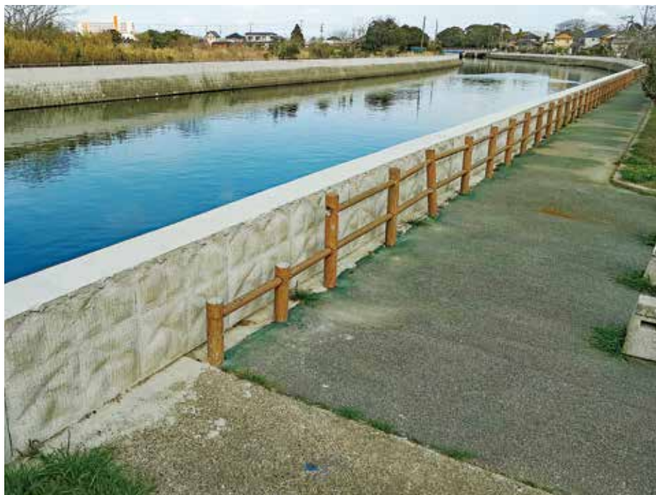
施工完了状況
