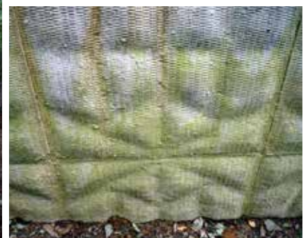
<上>刷毛仕上げ状況(左:前。右:後) <下>施工後4ヶ月で苔が生育を始めた状況
