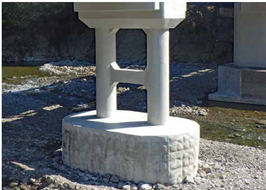
施工完了状況
