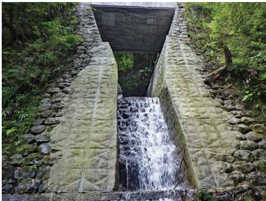
施工完了状況
