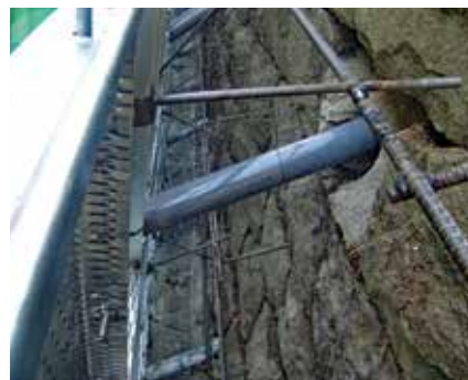
<上>施工前状況 <下>組立状況
