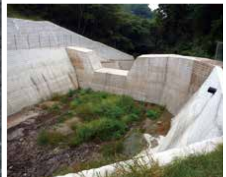
<上>折り曲げ加工状況 <下>施工完了状況
