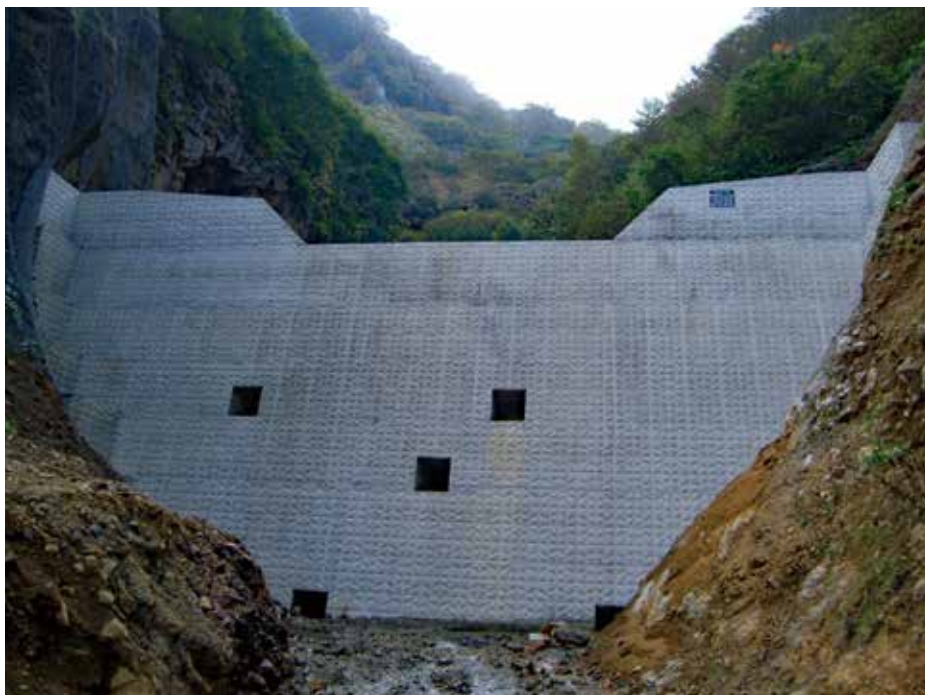
施工完了状況
