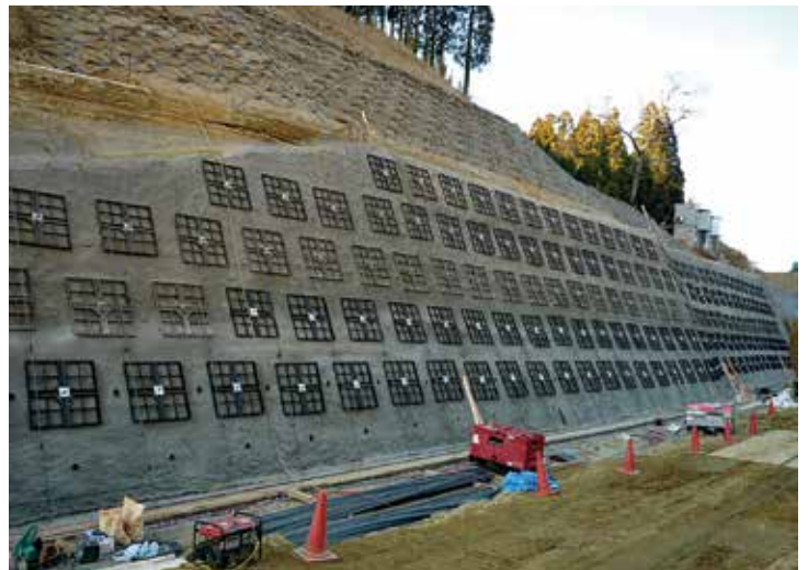
切土補強土工完了状況
