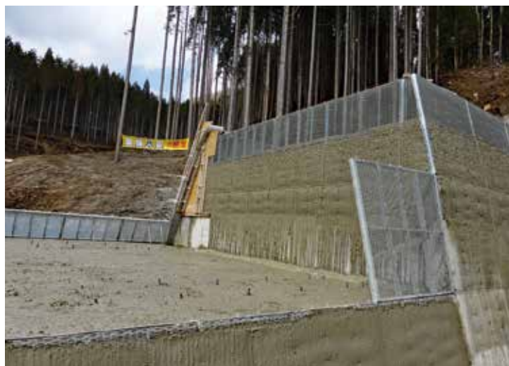
コンクリート打設状況
