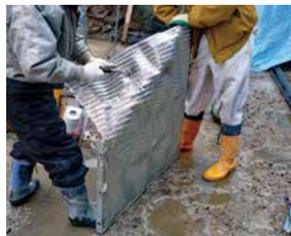
<上>組立状況（背面） <下>端部折り曲げ加工状況
