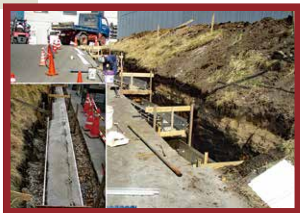
基礎コンクリートの施工
