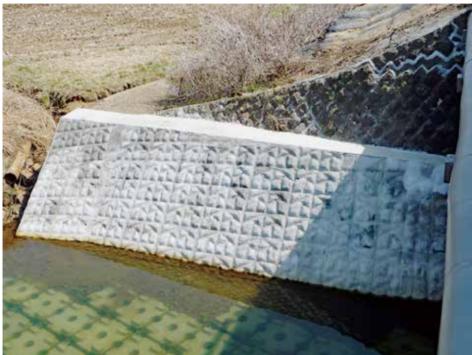
施工完了状況
