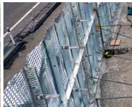
<上>施工前状況 <下>天端加工状況
