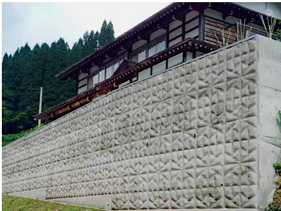
施工完了状況
