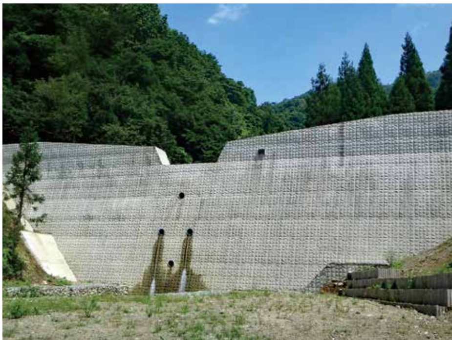
施工完了状況
