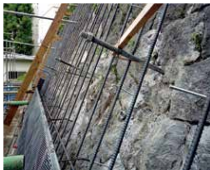
<上>配筋工、切土補強土工完了状況 <下>組立状況
