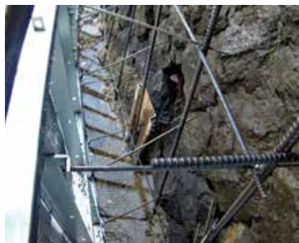
<上>施工当初状況 <下>組立状況
