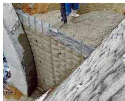
<上>組立完了状況 <下>コンクリート打設状況
