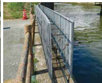
<上>下部固定状況 <下>組立状況
