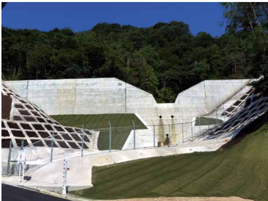
施工完了状況
