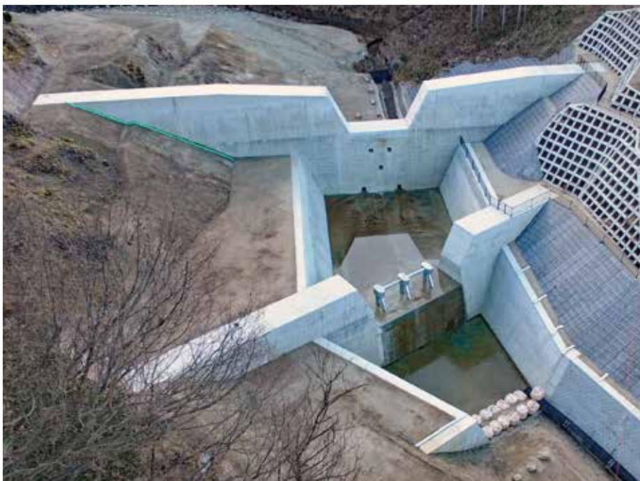
施工完了状況
