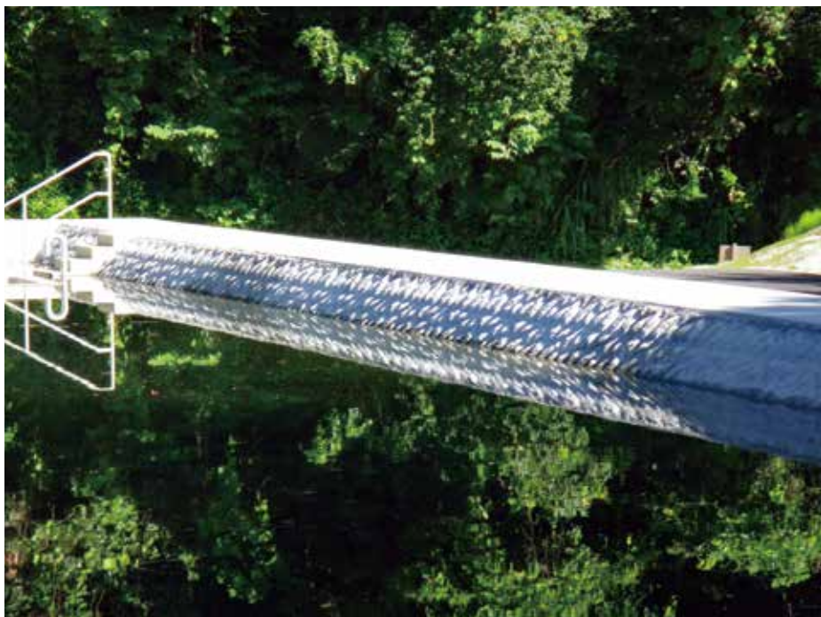
施工完了状況(満水時)
