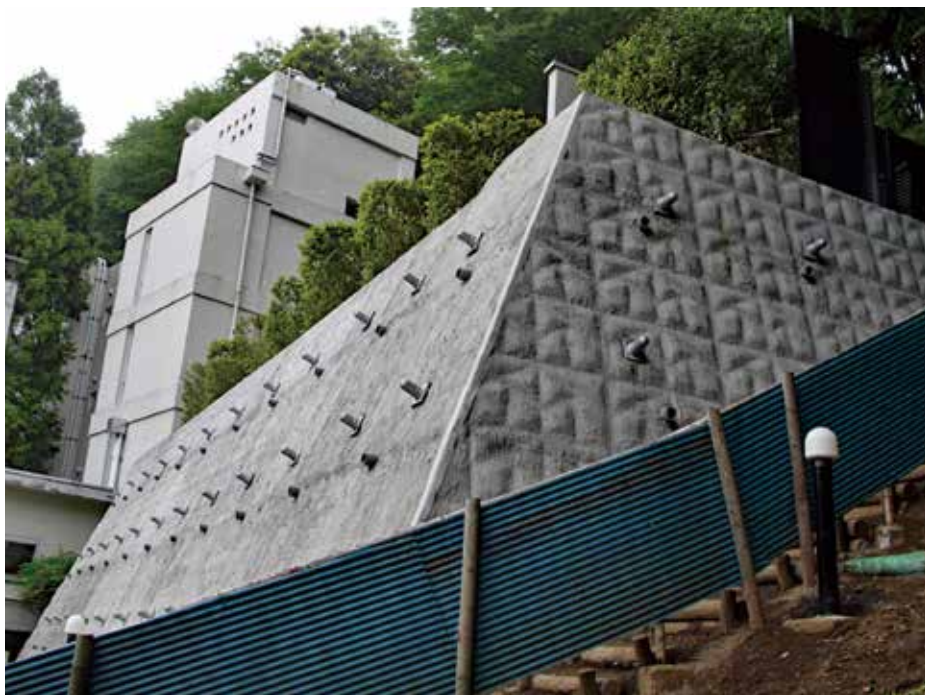
施工完了状況
