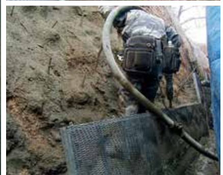
<上>施工前状況 <下>モルタル吹付状況
