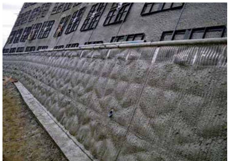
コンクリート打設状況
