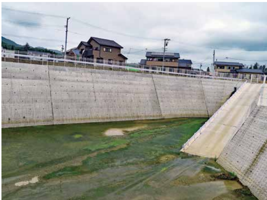
施工完了状況
