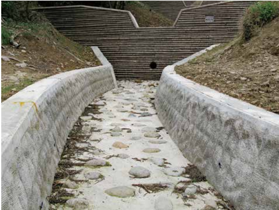
施工完了状況
