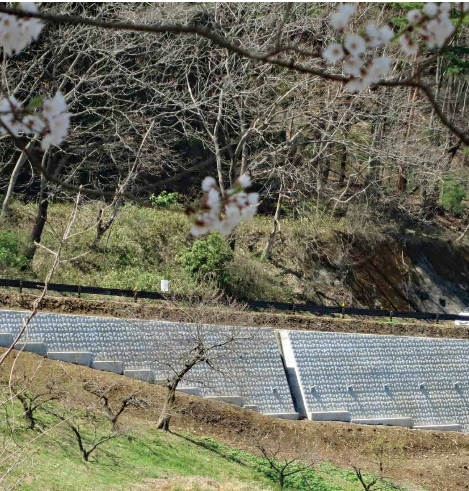
施工完了状況
