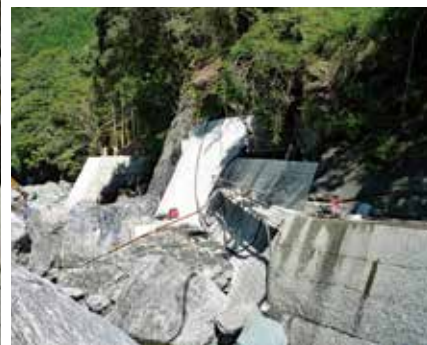
<上>索道によるコンクリート打設状況 <下>組立状況
