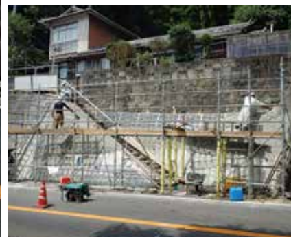
<上>施工前状況 <下>施工状況
