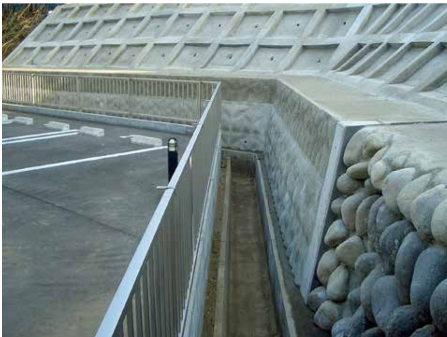
施工完了状況
