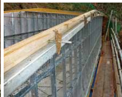
<上>切断加工状況 <下>天端加工状況
