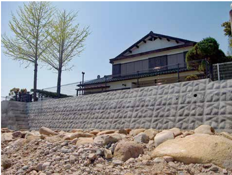
施工完了状況
