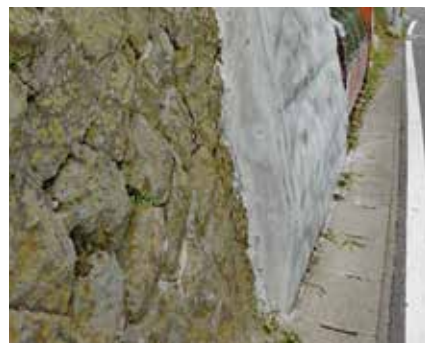
<上>施工前状況 <下>法尻部施工状況
