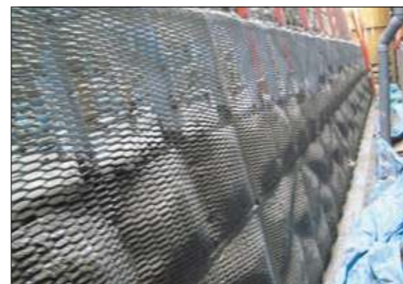
コンクリート打設状況
