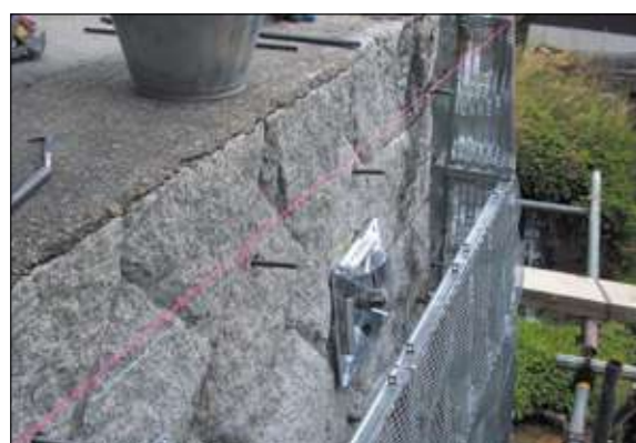
ロックボルト 設置状況
