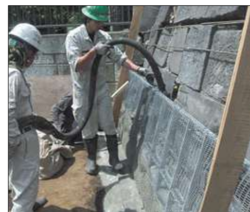
コンクリート打設
