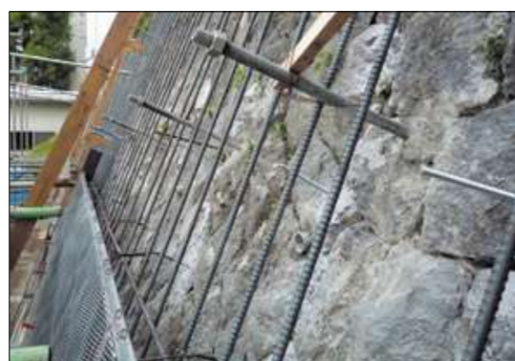
ロックボルト 挿入状況
