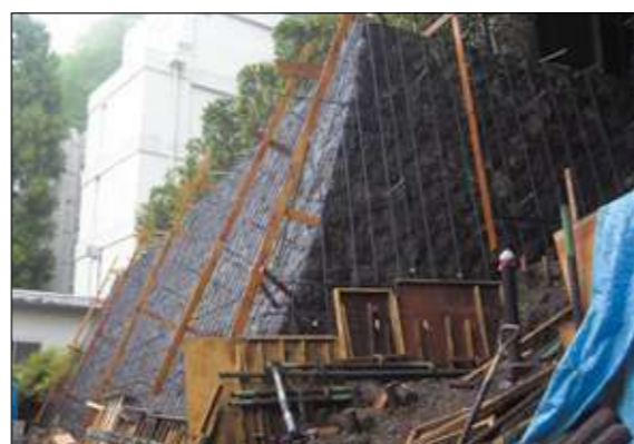
鉄筋設置状況
