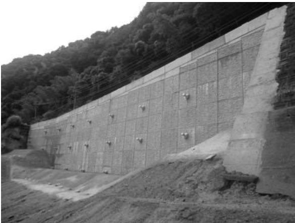
写真 6. 11. 1 グラウンドアンカー (全景写真)
