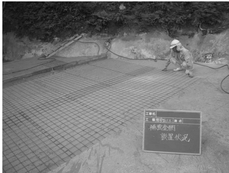
写真6.10 溶接金網設置状況
