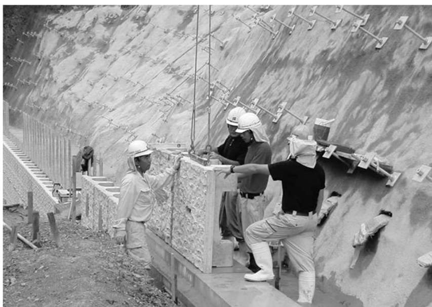
写真4.1 吊り金具使用例 (PCWパネル)
