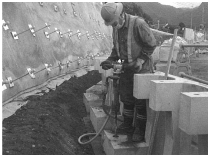
写真 6.8 カウンターアンカー工削孔状況
