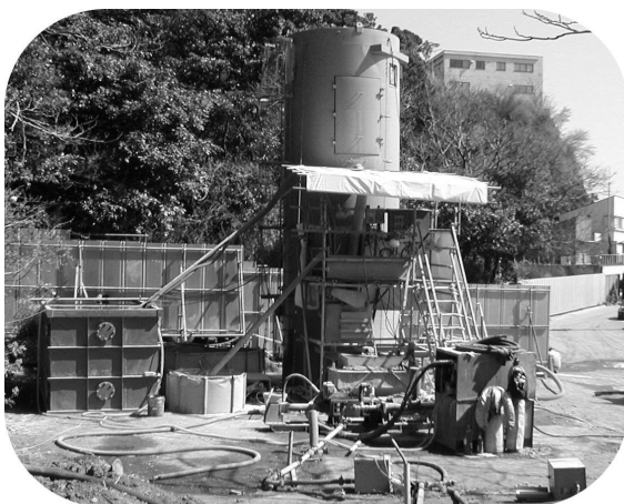
写真5.1 現場練方式プラント
