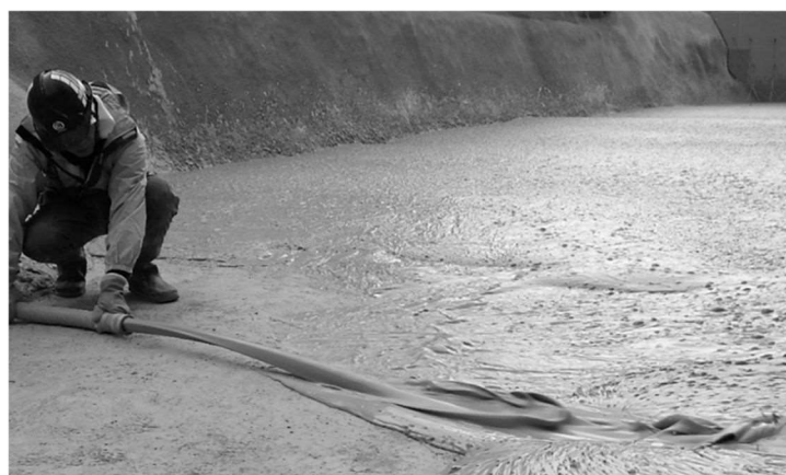
写真 6.11 気泡混合軽量材打設状況
