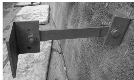
写真6.4.2 設置完了時_連結プレート水平設置
