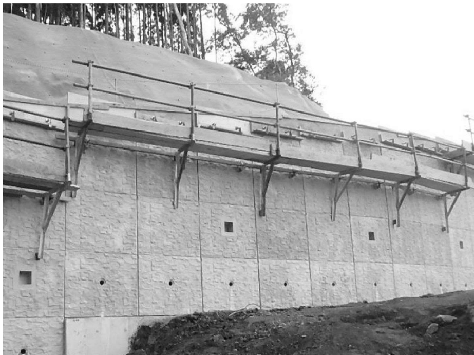
写真 6.13 作業足場_設置例
