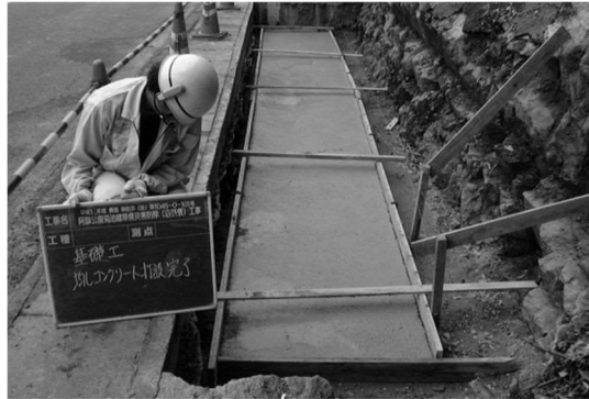
写真 6.6 均しコンクリート打設状況
