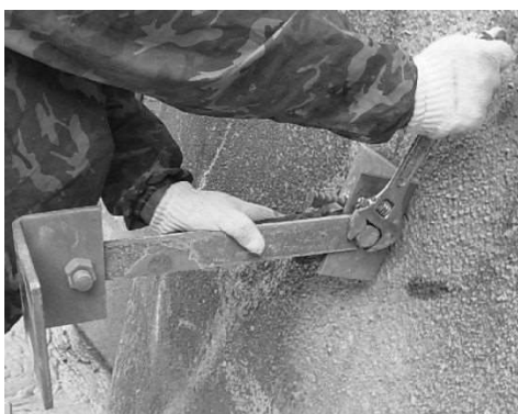
写真6.4.1 PCW頭部プレート取付状況
