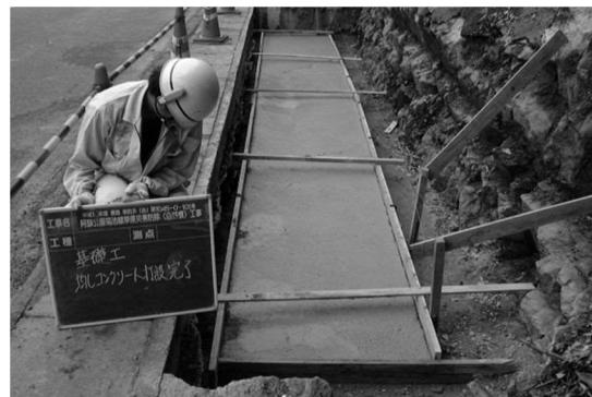
写真 6.6 均しコンクリート打設状況
