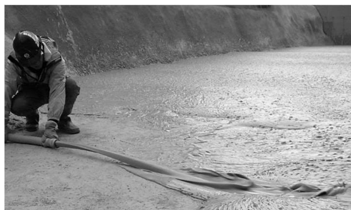
写真 6.11 気泡混合軽量材打設状況
