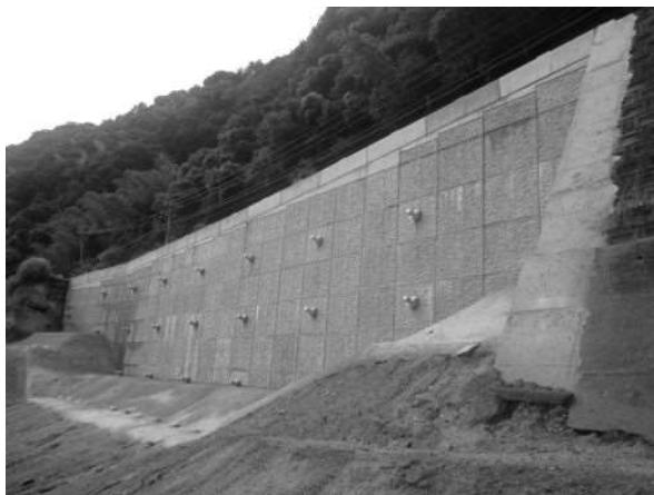
写真 6.11.1 グラウンドアンカー（全景写真）
