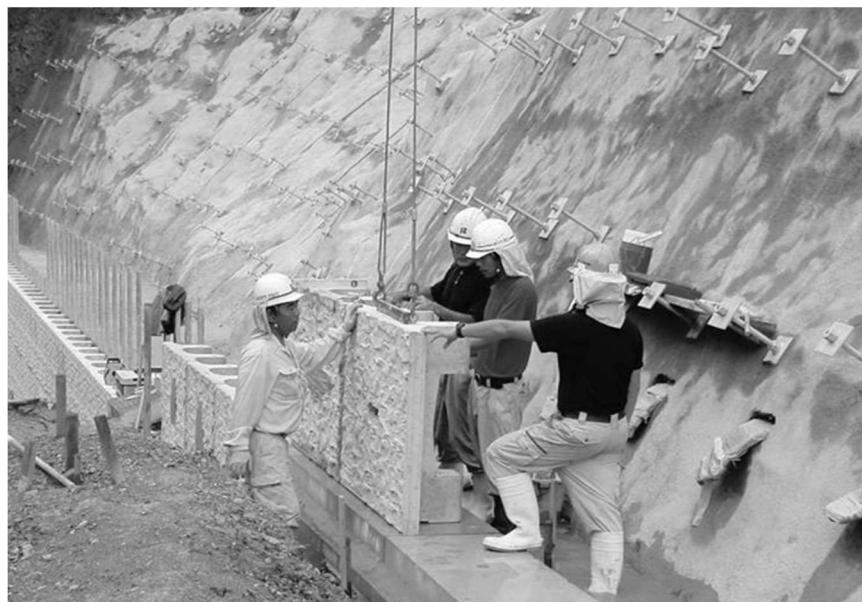
写真4.1 吊り金具使用例 (PCWパネル)
