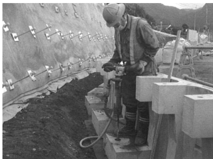
写真 6.8 カウンターアンカーア削孔状況
