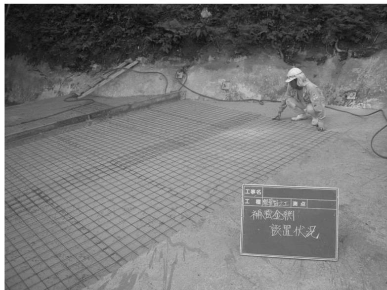
写真6.10 溶接金網設置状況
