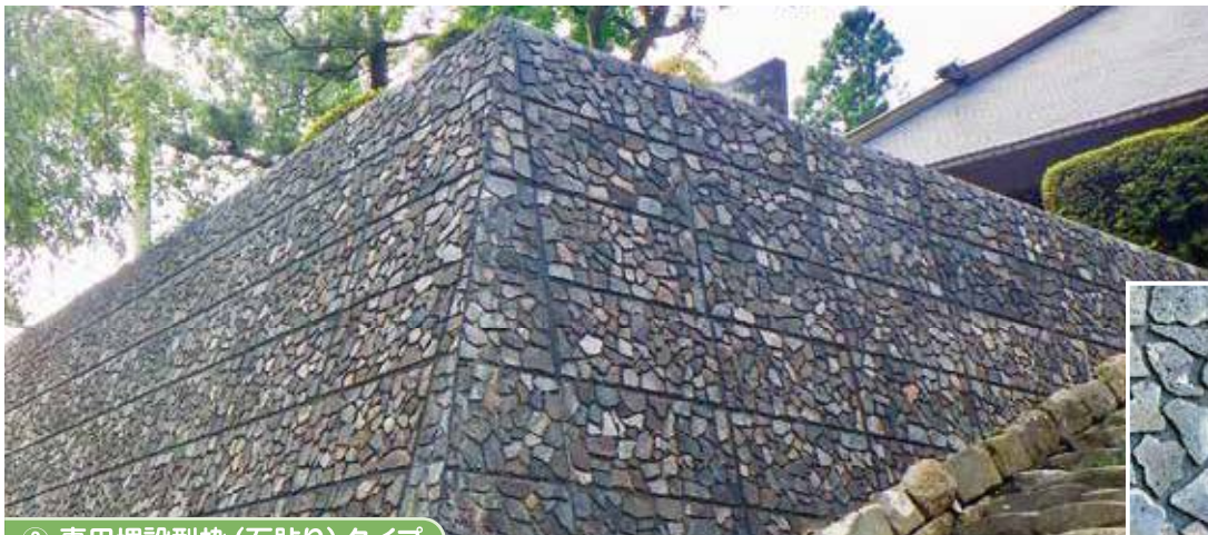
② 専用埋設型枠（石貼り）タイプ
