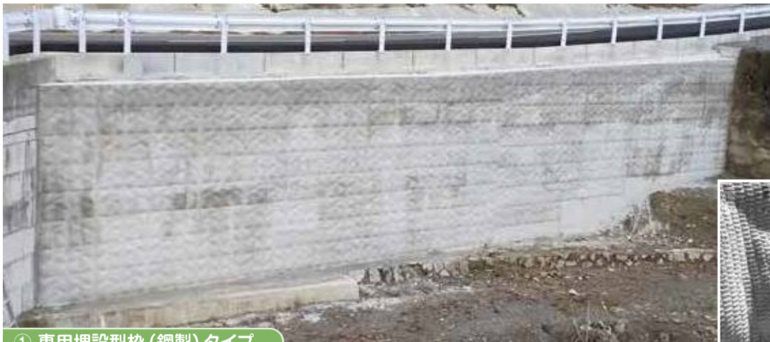
① 専用埋設型枠（鋼製）タイプ
