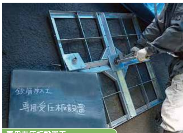
専用支圧板設置工
