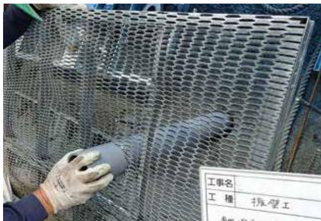
専用埋設型枠(鋼製)設置工(下段)
