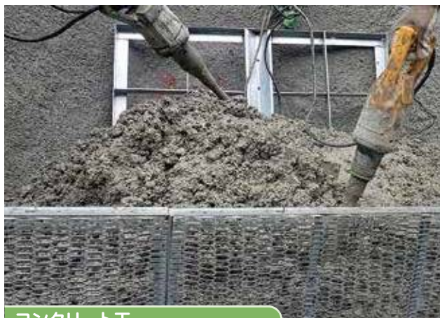
コンクリート工
