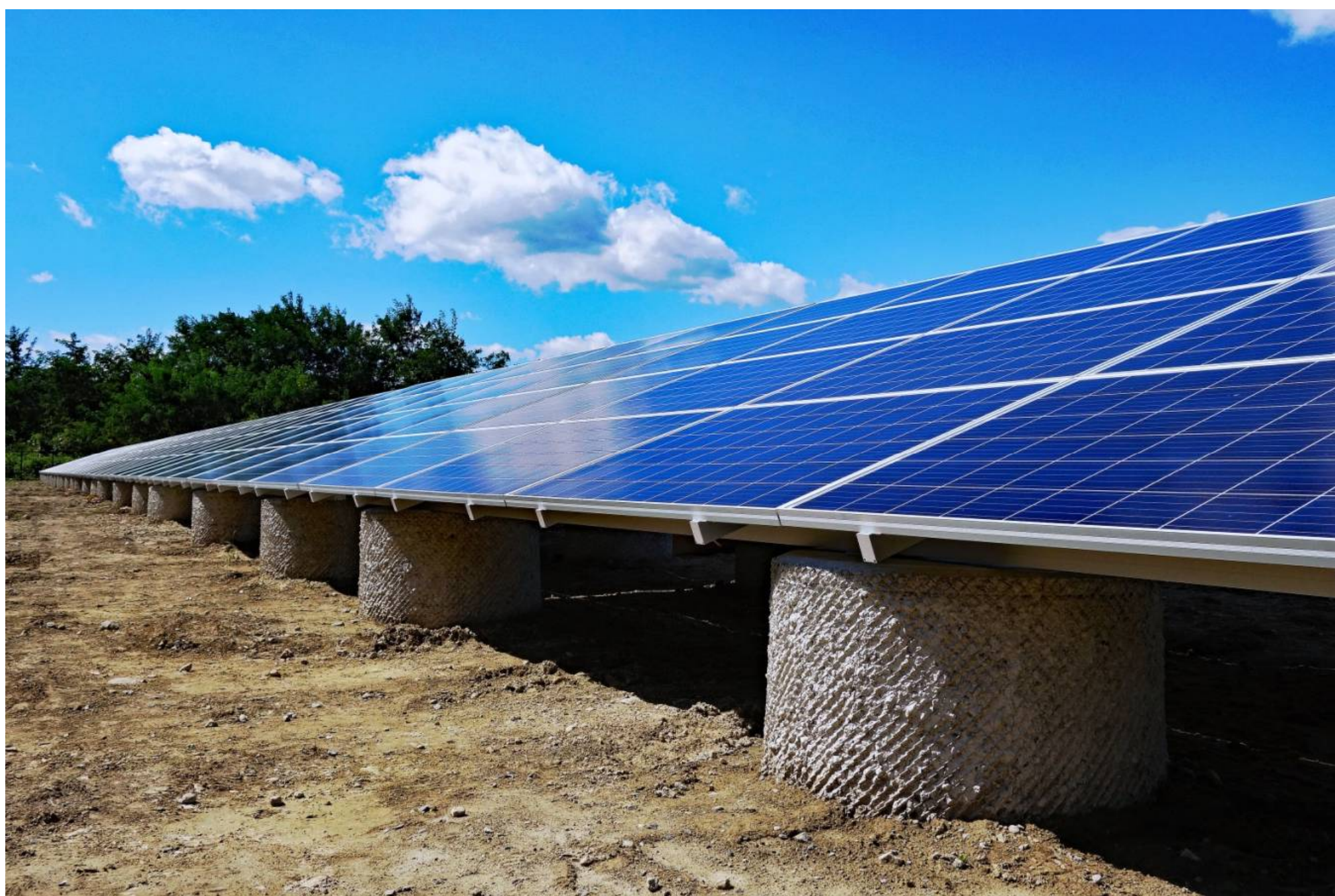
使用例：太陽光パネル基礎コンクリート
