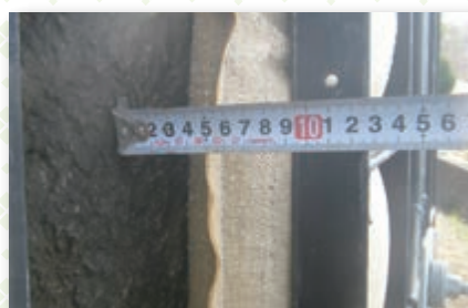
地山と受圧板を密着させます！
