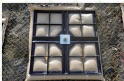
グラウト充填完了
