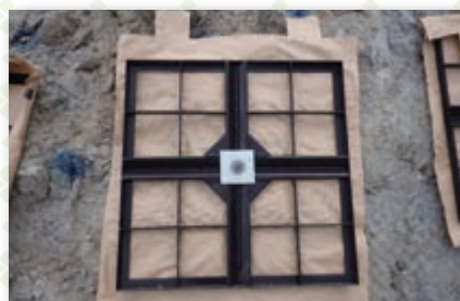
シート設置完了 (写真は田パネル DP-R1000)
