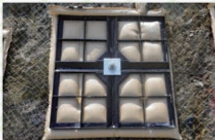
グラウト充填完了
