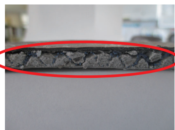
硬化後の断面状況
