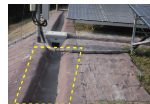
素掘側溝、排水路補強
